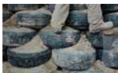
写真1: 廃材のタイヤと泥を利用して壁をつくる(《オフグリッドの生——切断をめぐって》(0:34:30))
