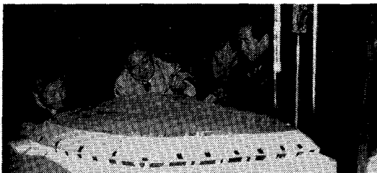
写真1 風洞内部に設置された模型
