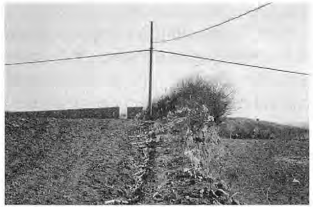
図5 西壁の現状（北から）
