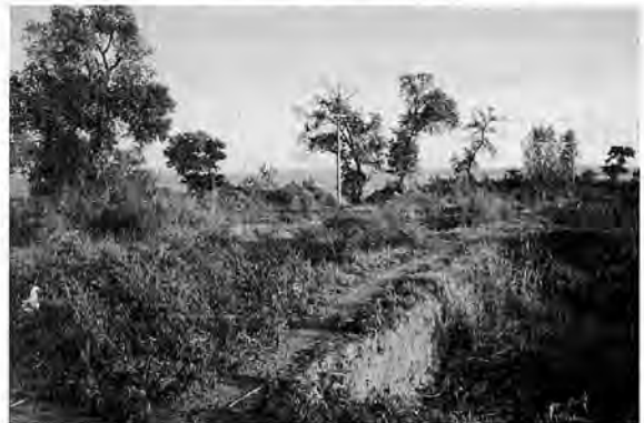
図 20 二龍湖古城 城内から城壁を見る
