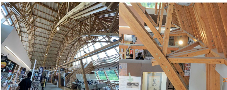
図 3-2-2 アーチトラス 図 3-2-3 在来工法の接合部
