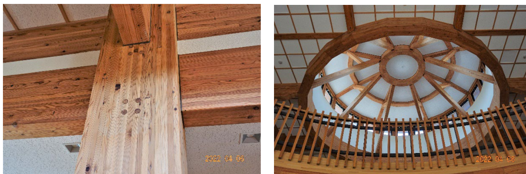
図 3-3—2、3 集成材接合部（柱と梁の材料は異なる）、大スパン空間
