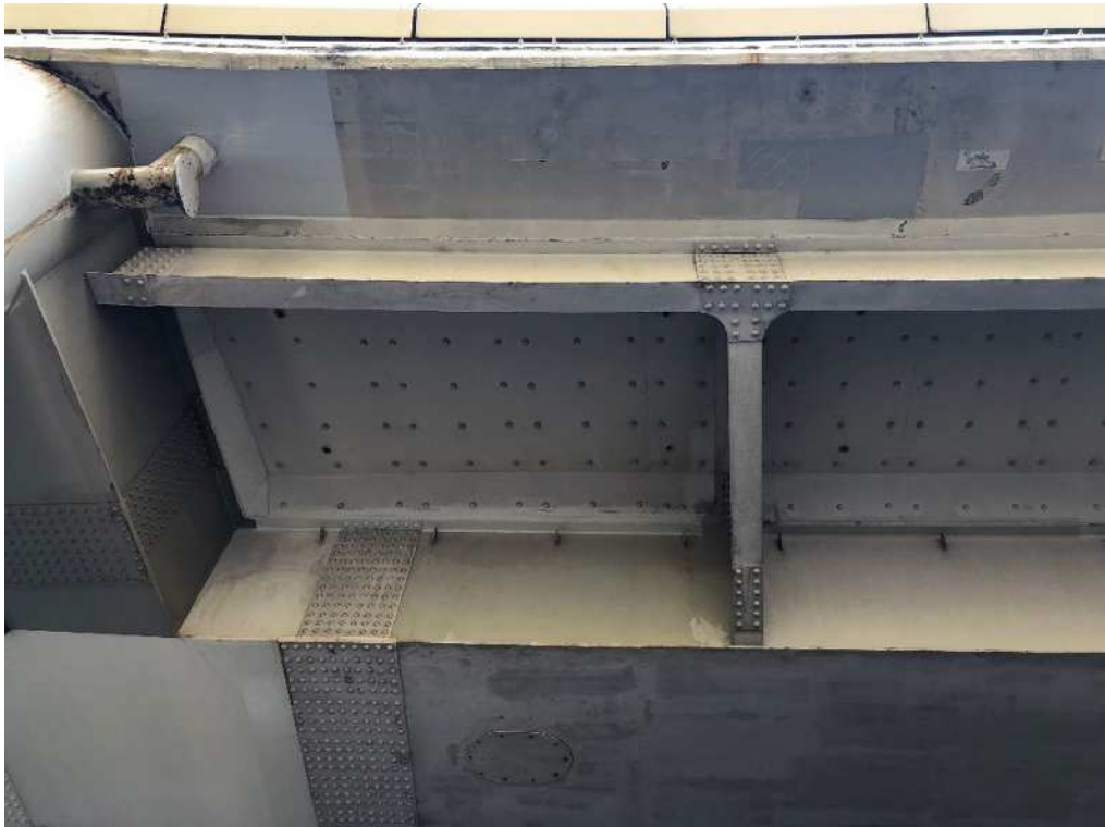
写真 1-4 軽量床版の補強状況（全面鋼板補強）
