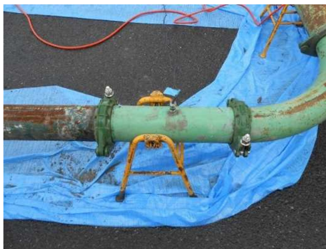
写真4-4 圧送試験状況 (b) 圧力計の設置状況
