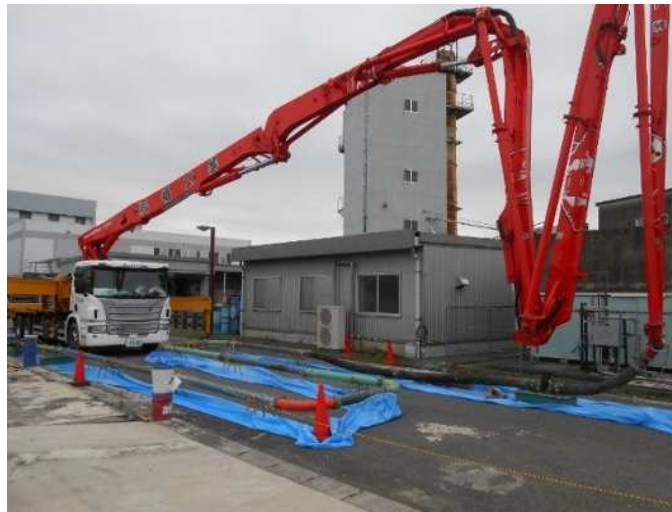
写真4-3 圧送試験状況 (a) 配管状況
