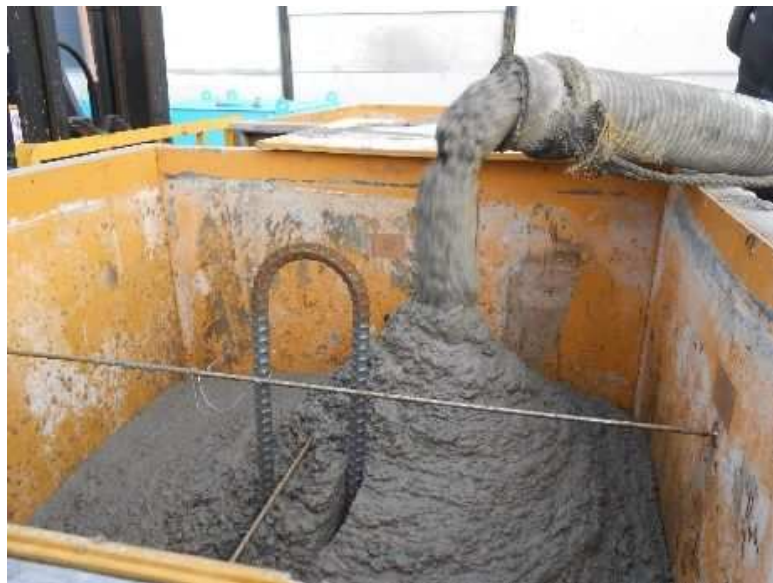
写真4-5 圧送状況（筒先）ケースF
