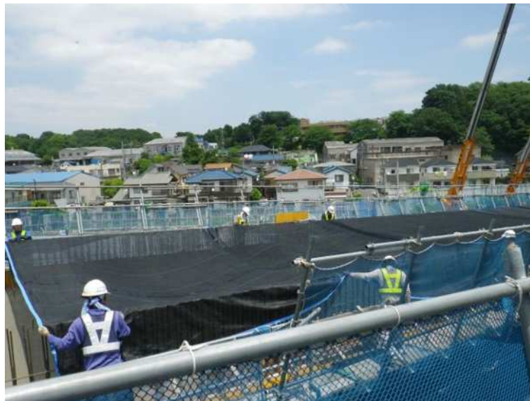
写真 2-6 遮光シート設置状況
