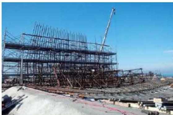
図-4.12 外周網筋の組立状況
