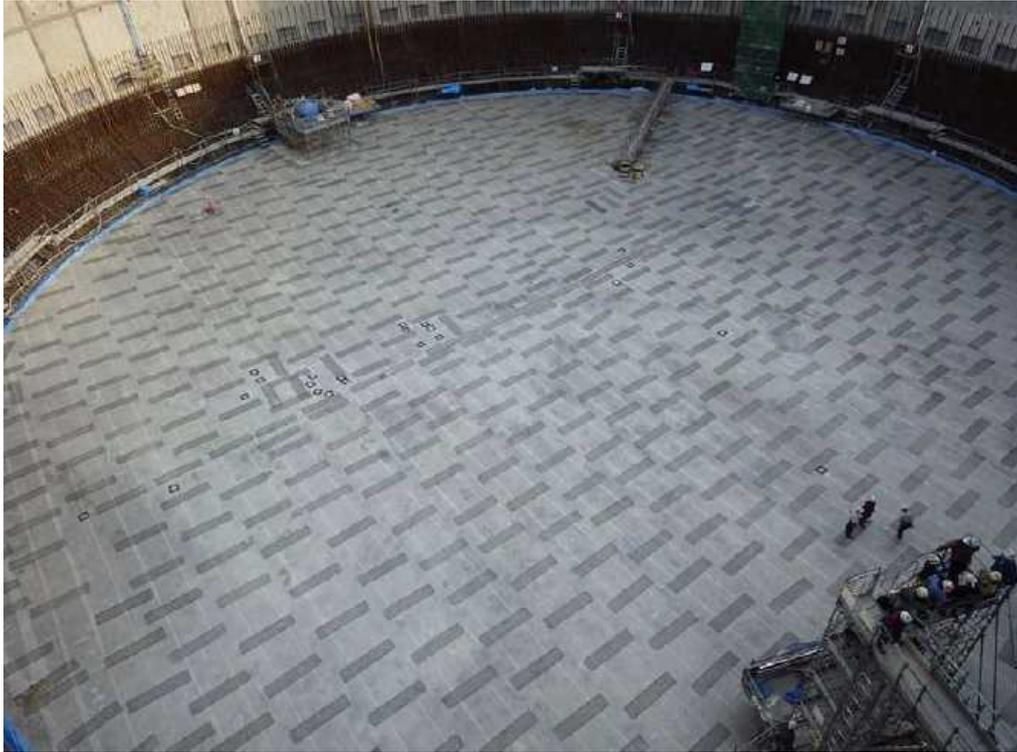
図-D21 底版工事（コンクリート養生・気泡緩衝材敷設）
