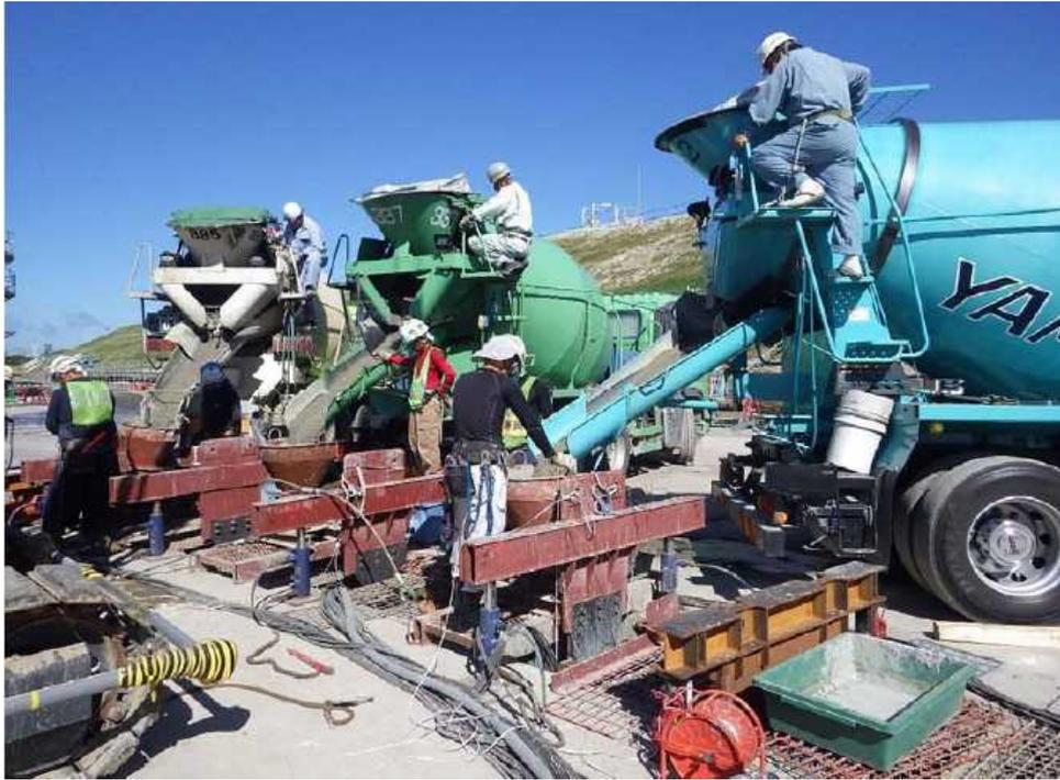
図-D5 連続地中壁工事（コンクリート打設）
