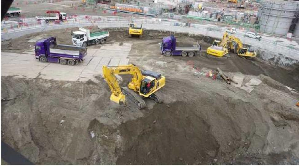
图-D7 内部掘削工事（一次掘削）
