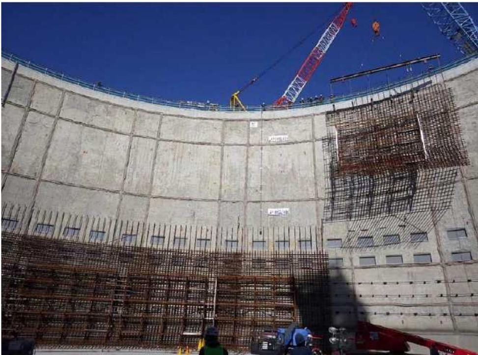
図-D16 底版工事（外周網筋ブロック建て込み状況）
