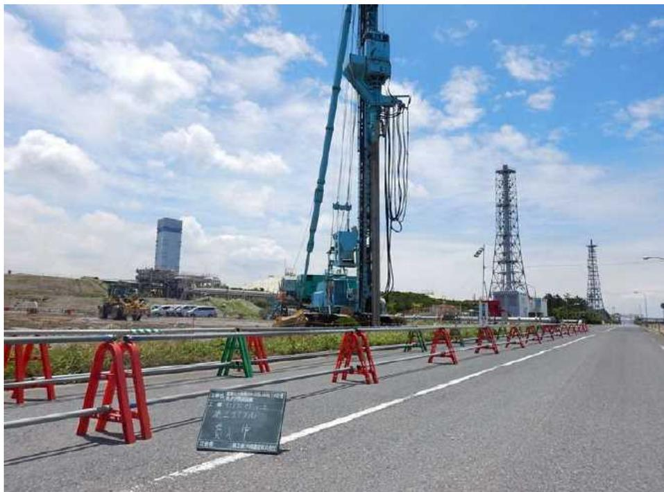
図-D1 地盤改良工事（サンドコンパクションパイル工法・砂杭貫入中）
