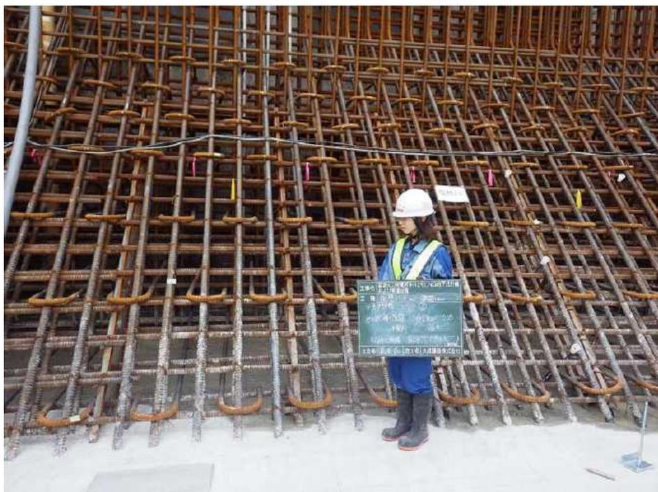
図-D23 躯体工事（1 リフト・鉄筋組立状況）
