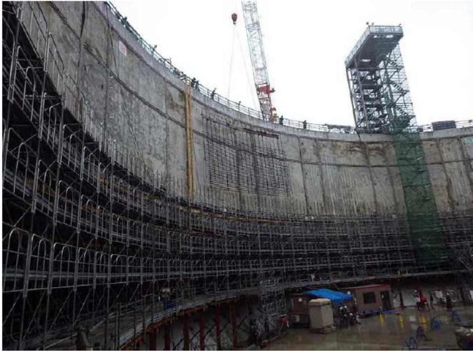
図-D25 躯体工事（2 リフト・鉄筋建て込み状況）
