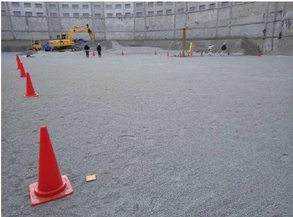
图-D12 底部工事（排水碎石層成形）
