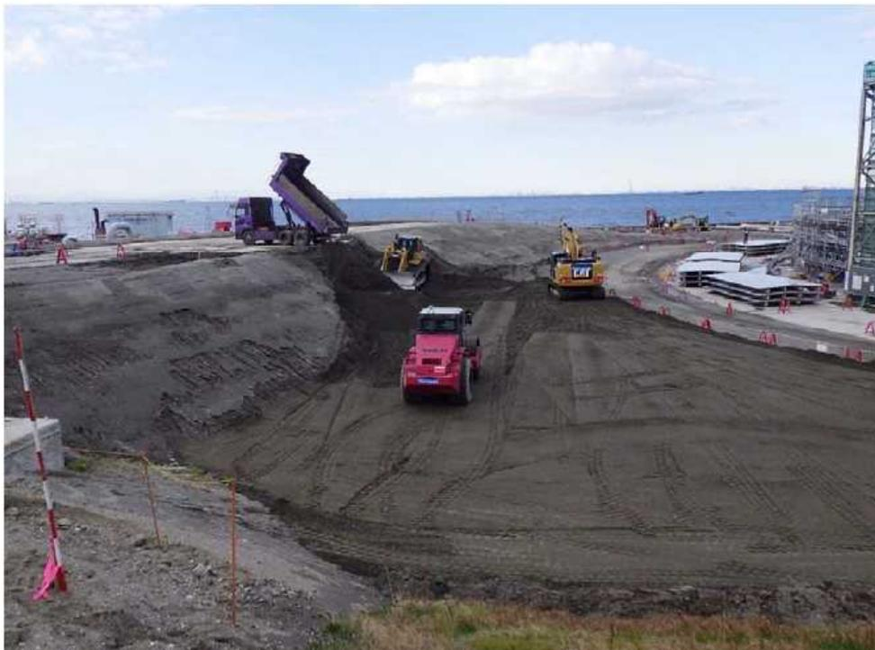
図-D30 盛土工事 (現地発生土・転圧状況)
