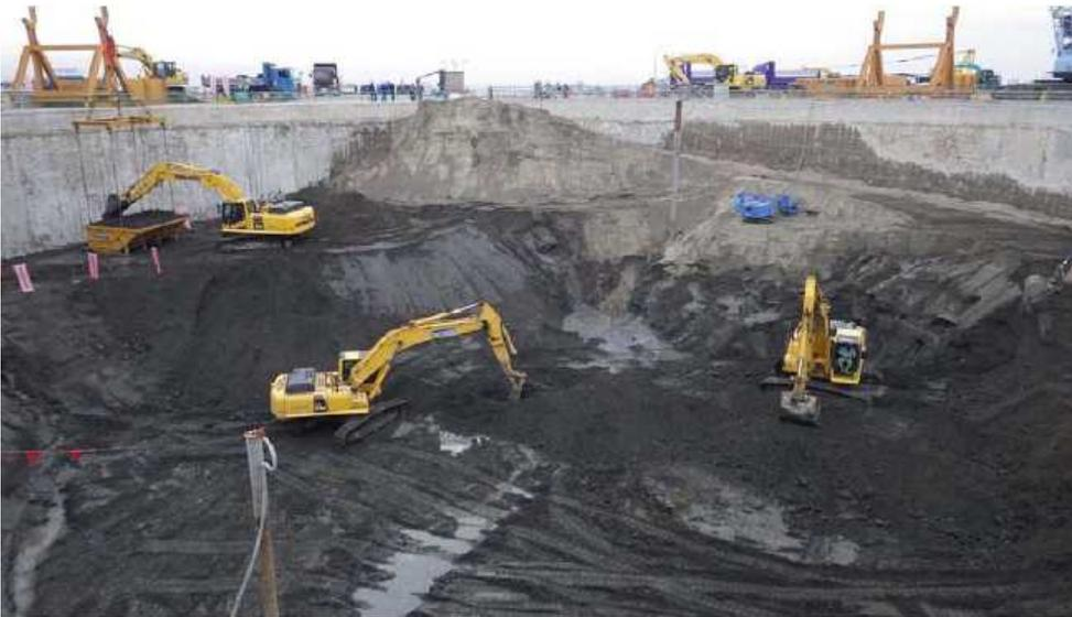
图-D8 内部掘削工事（二次掘削）
