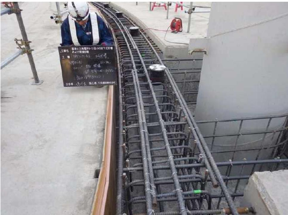
図-D6 連続地中壁工事（頭部コンクリート構築）
