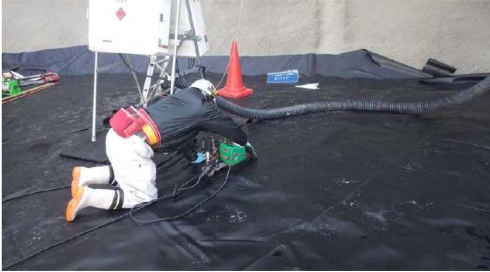
図-D13 底部工事（防水シート敷設）
