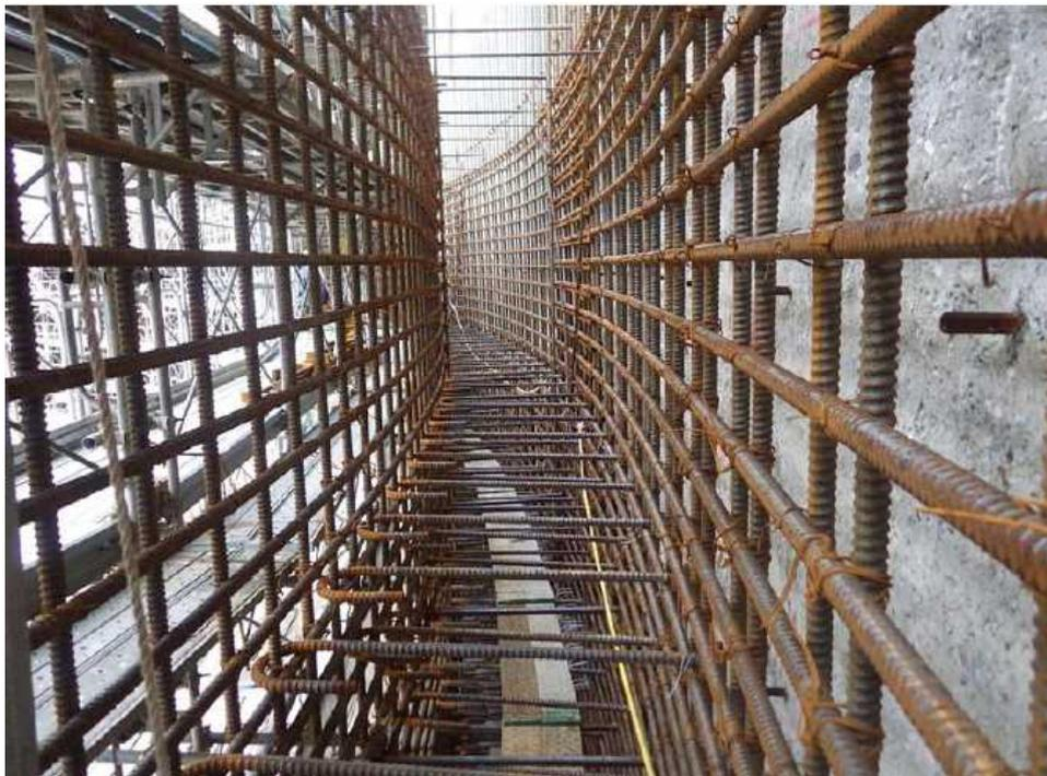
図-D26 躯体工事（2 リフト・鉄筋組立状況）
