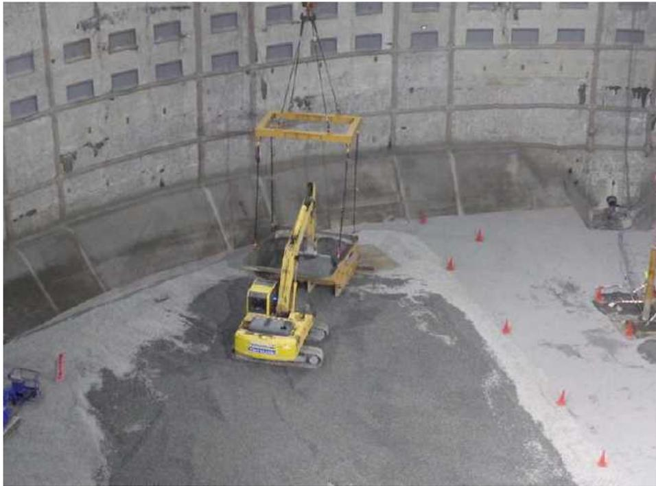
图-D11 底部工事（碎石投入）
