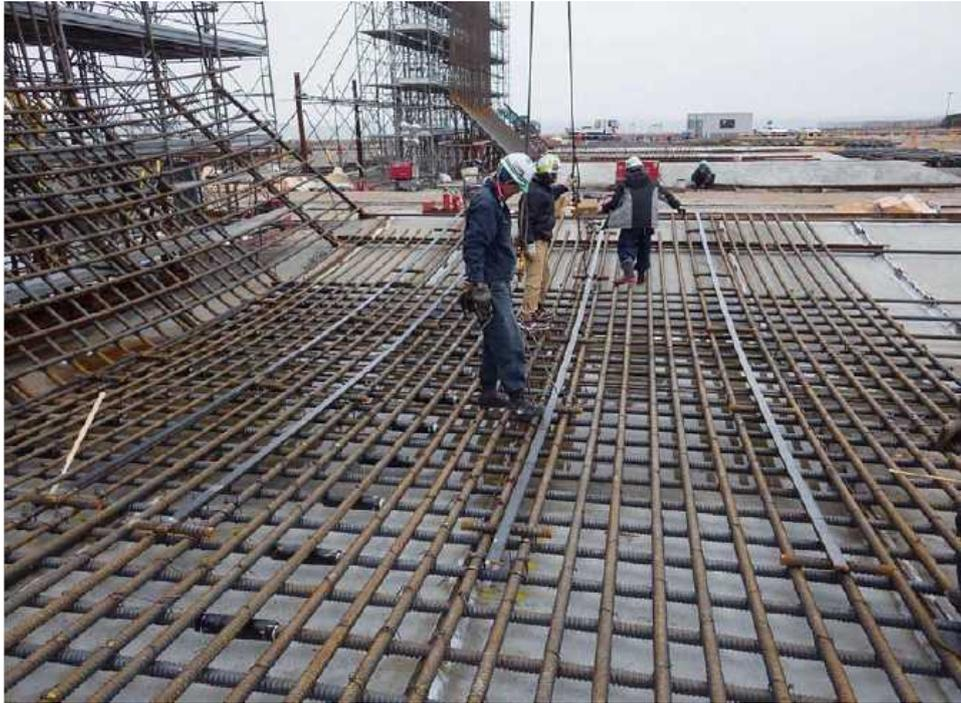
図-D15 底版工事（外周網筋ブロック，陸上組立）
