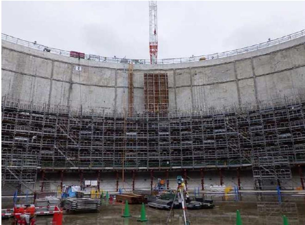
図-D27 躯体工事（2 リフト・型枠建て込み状況）
