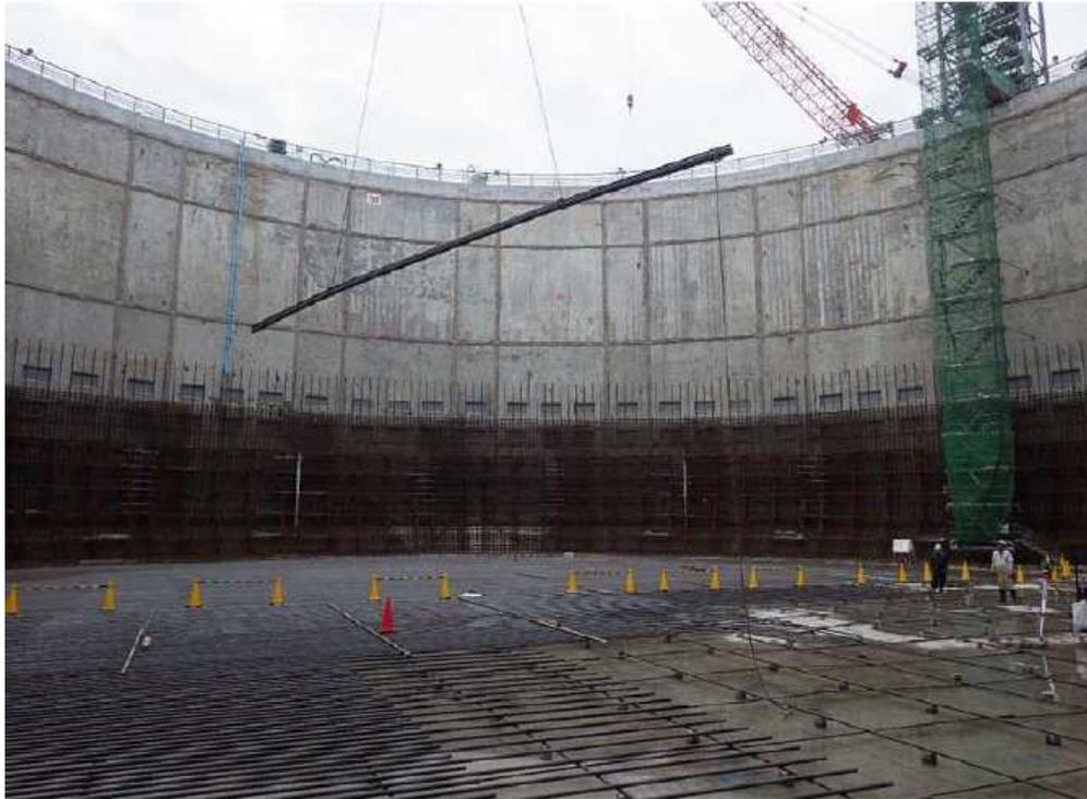
図-D17 底版工事（下筋組立状況）
