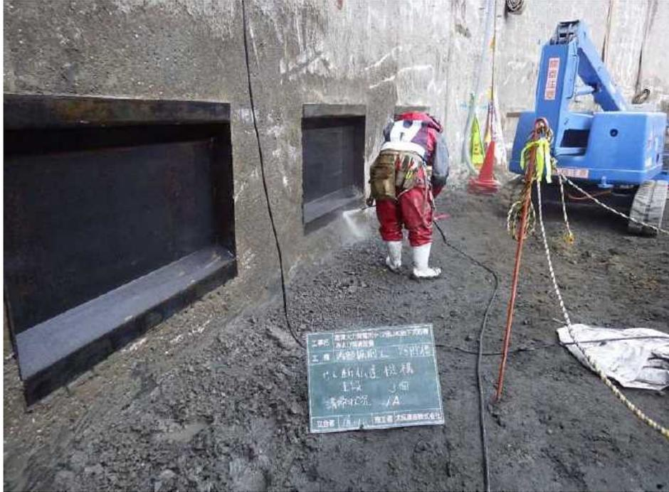
図-D9 内部掘削工事（せん断伝達機構部清掃）
