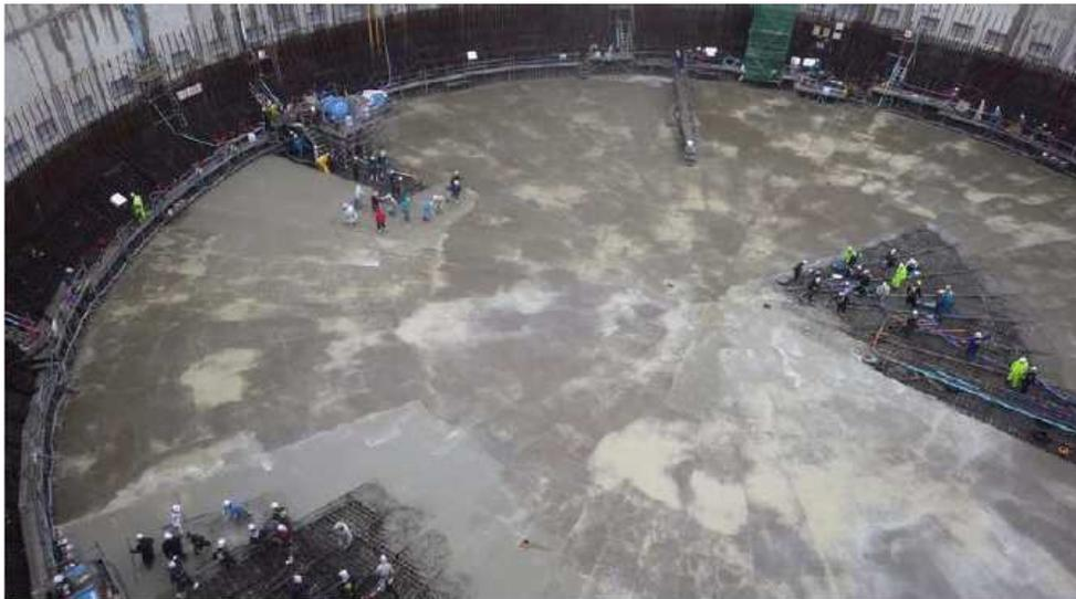
図-D20 底版工事（コンクリート打設・仕上げ）
