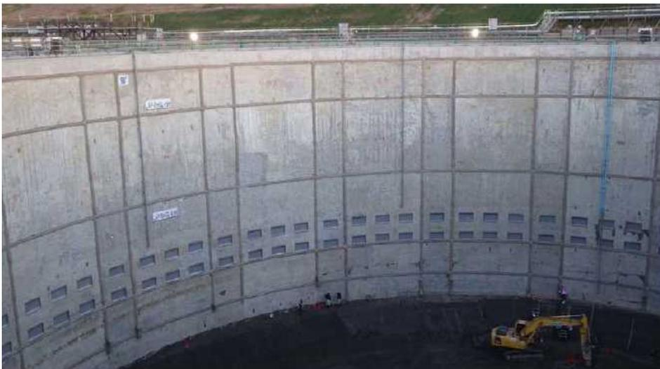
図-D10 内部掘削工事（床付け）
