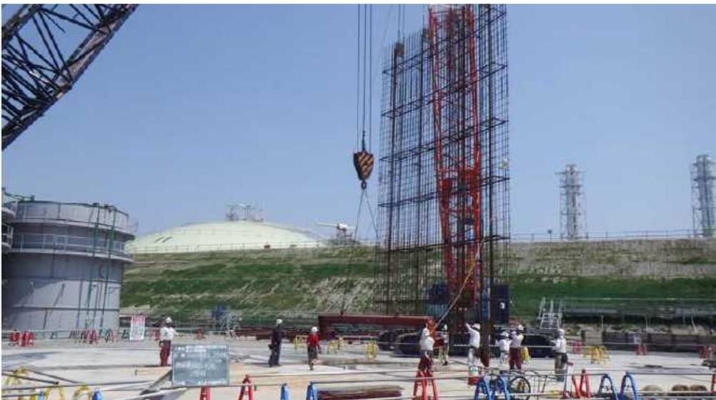
図-D4 連続地中壁工事（鉄筋かご建て込み状況）
