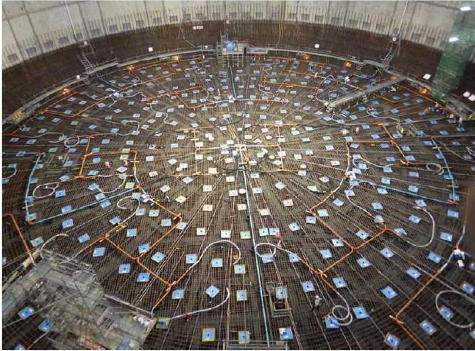
図-D19 底版工事（上筋組立完了，コンクリート打設準備）
