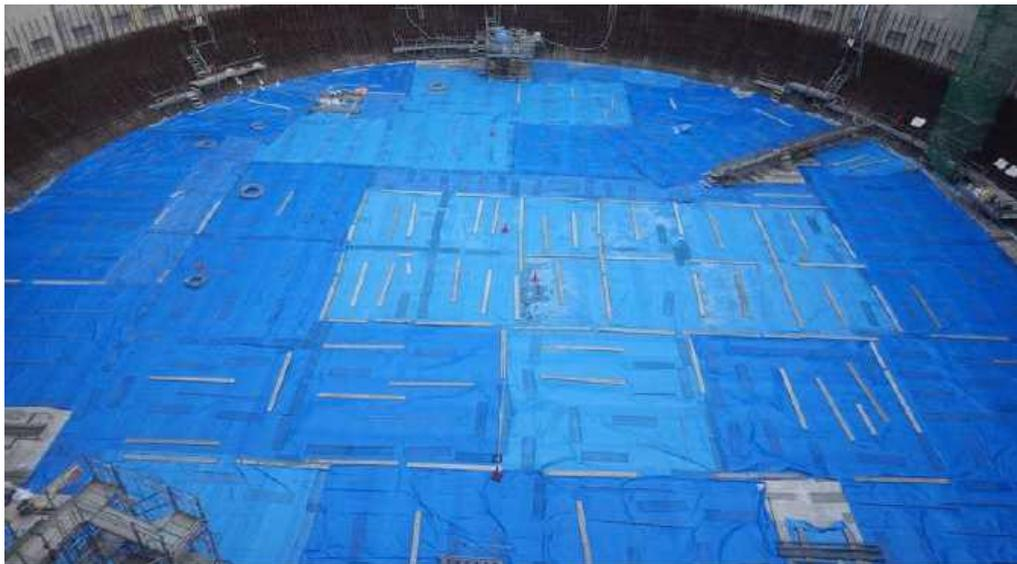
図-D22 底版工事（コンクリート養生・ブルーシート敷設）
