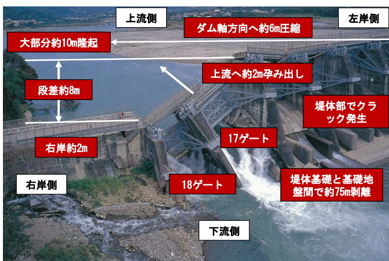
図 A2.2.1-2 石岡ダム被害の概要([4]に加筆)
