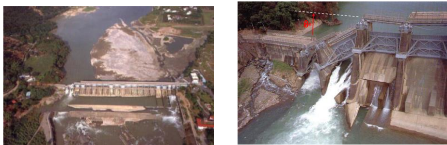
図 2.2.1-6 断層により崩壊した石岡ダムのゲート[13]
