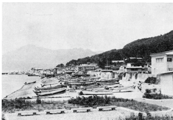
図 7-25. 大浦漁港防潮堤
