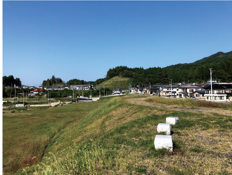
図 9-11. 災害危険区域（左）と復興地（右）を分ける防災緑地のマウント（田の浜集落）
