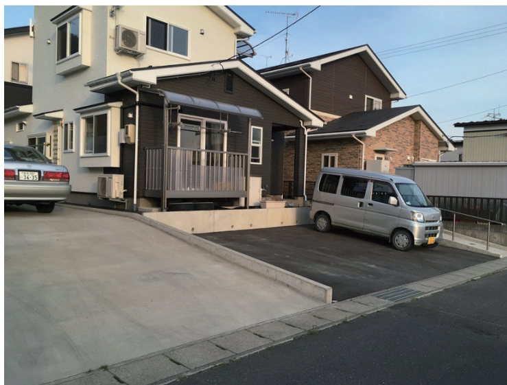
図 9-13. 復興地内で嵩上げされた敷地に新築された住宅（田の浜集落）
