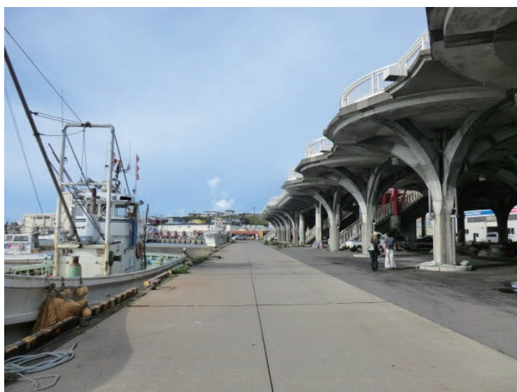
青苗漁港人工地盤
