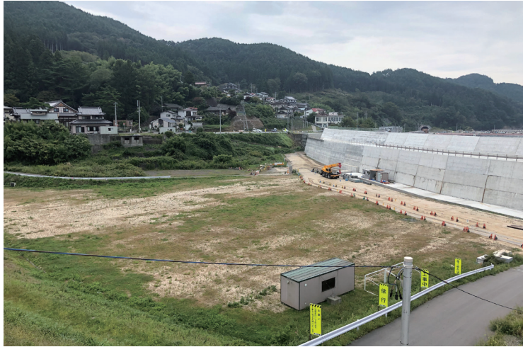
図 9-32. T.P.+14.5m に嵩上げされた防潮堤と災害危険区域（仮設グラウンド）（小白浜集落）
