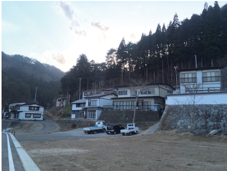
図 6-2. 低地部と復興地を繋ぐ集落道の整備箇所（平井賀地区）
