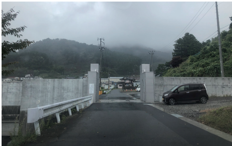
図 9-33. 敷地通りに設置された陸閘（小白浜集落）
