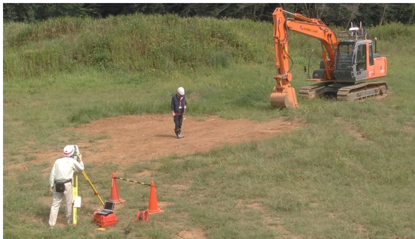
図 6-16 実験用フィールドにおける計測状況
