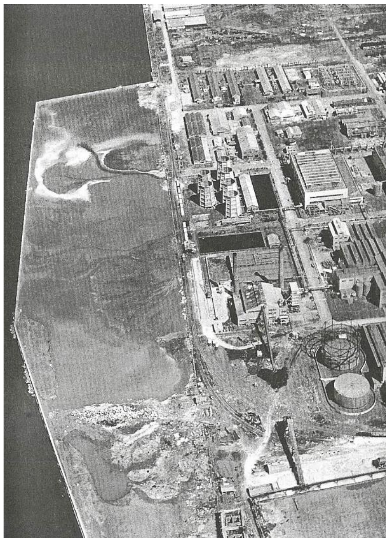
図 5-32 建設中の日本軽金属清水工場 [383, p. 151]
