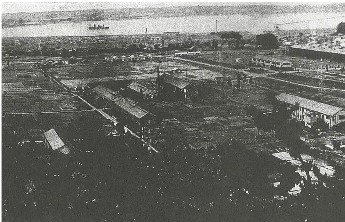
図 5-39 建設中の日立製作所清水工場 [383, p. 154]
