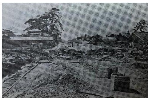
図 5-20 施工中の 1.3.2.大曲波止場線 [383, p. 127]
