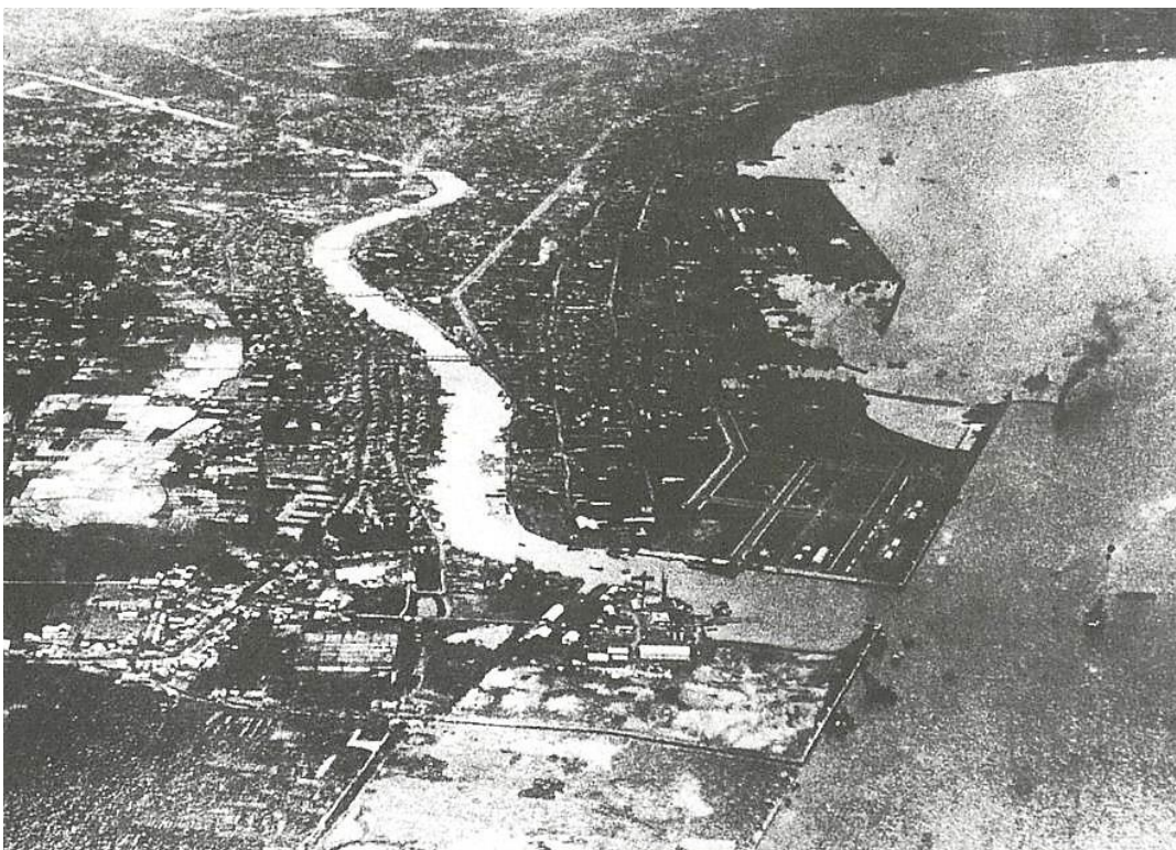
図 5-26 建設中の日の出埠頭 [383, p. 90]
