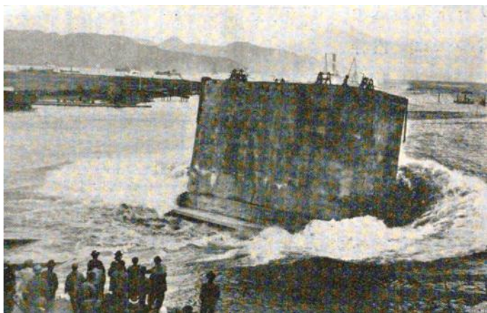
図 2-33 函塊の進水（清水港） [244, p. 100]
