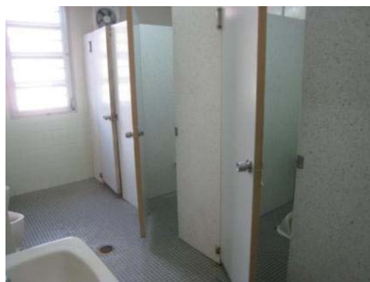
トイレ (施設 A)
