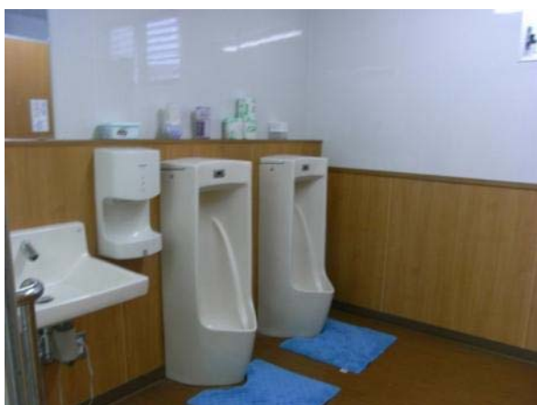
改修されたトイレ (施設 B)
