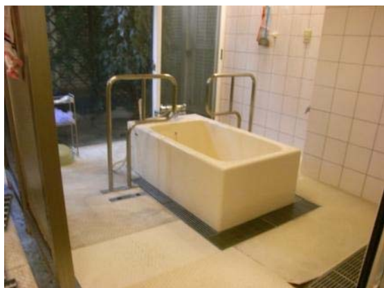
桧風呂より改修された浴室 (施設 A)
