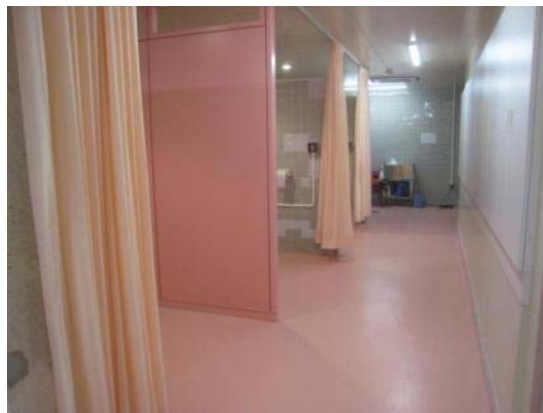
改修されたトイレ (施設 C)
