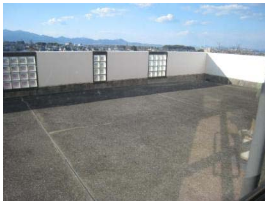
屋上 (施設 A)
