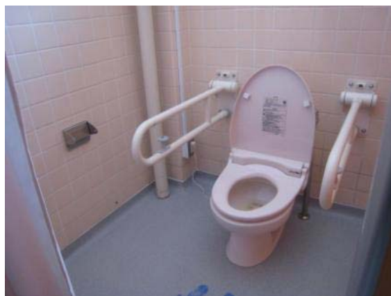
改修されたトイレ (施設 D)
