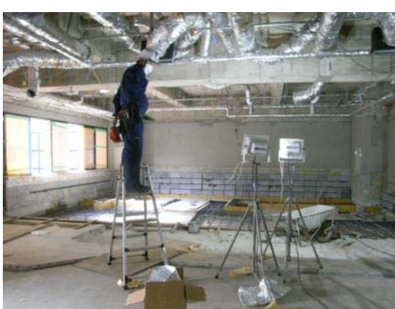
機械浴設置と合わせた浴室改修工事 (施設 A)
