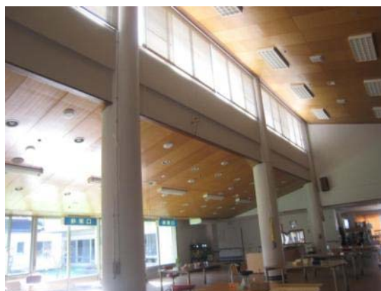
改修されたホール (施設 C)
