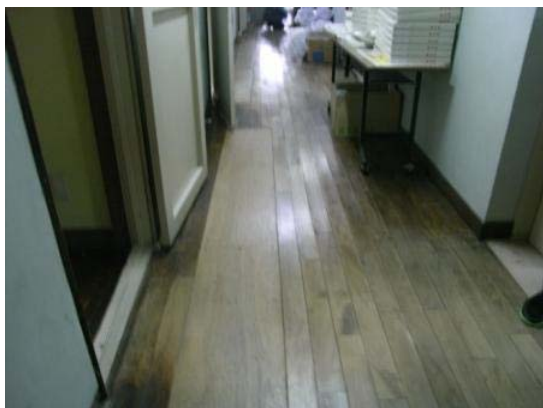
劣化したため自らが施工し、修繕した床 (施設 A)
