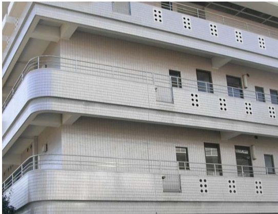
改修後の外壁の様子 (施設 A)
