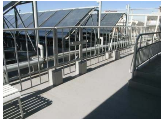
改修後の屋上の様子 (施設 A)
