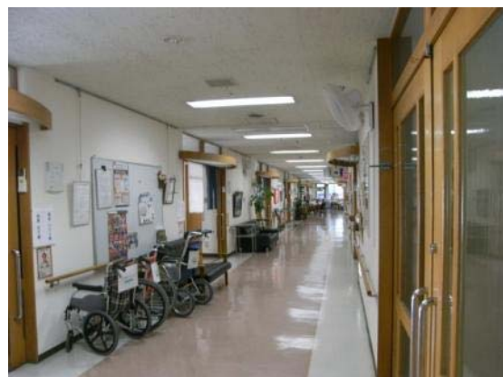
空調等の改修を行った室内廊下 (施設 A)
