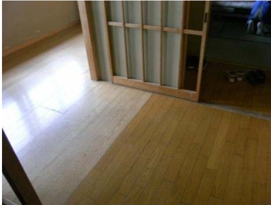
小上がりから段差を解消した床面 (施設 A)
