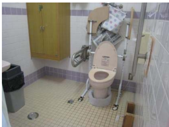
トイレ (施設 A)
