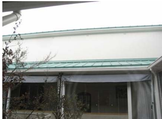
屋根修繕とともに修繕を行った外壁 (施設 A)
