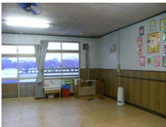
修繕されている床・壁 (施設 D)
