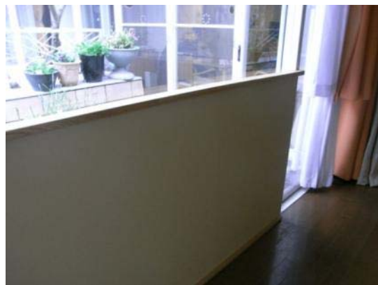
自らが施工した廊下窓周りの防寒対策壁 (施設 A)
