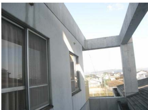
外壁 (施設 B)
