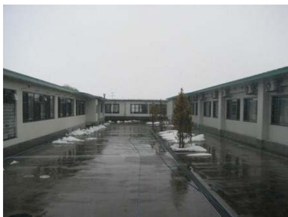
修繕がなされている外壁・屋根 (施設 A)
