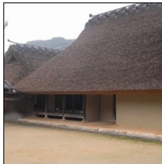
図 5 その他土壁 (Ex.中塗り仕上げ)
