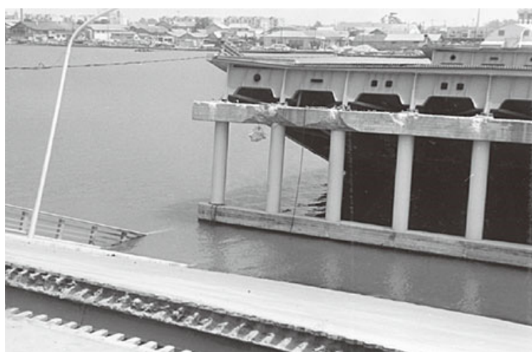
図 2-6 新潟地震における昭和大橋の被害[57]
