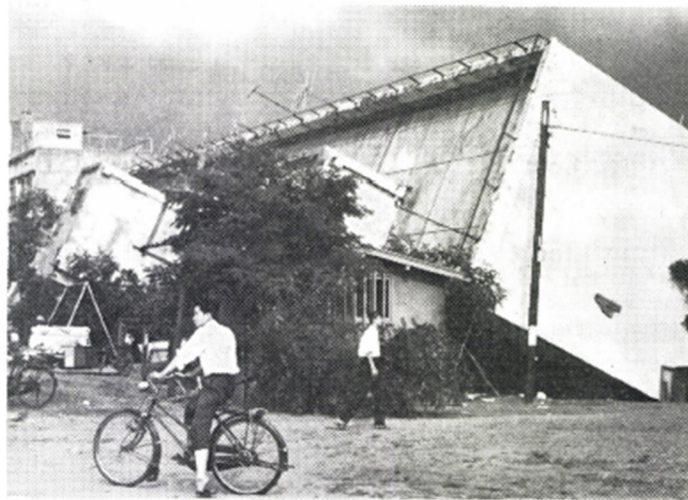
図 2-5 新潟地震における川岸町県営アパートの被害[9]
