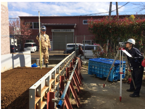
図 3-3-13 試験盛土天端高測定
