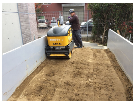
図 3-3-15 1ton 振動ローラーで締め固め
