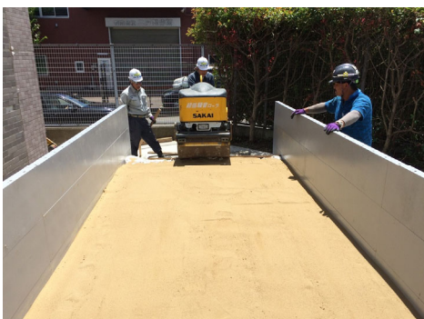
図 3-3-7 干渉層の締め固め
