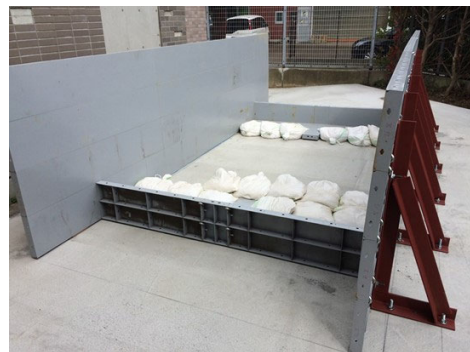
図 3-3-4 妻壁設置・固定
