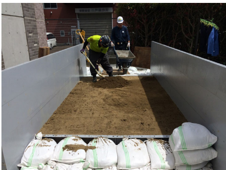
図 3-3-5 緩衝層の土投入・敷き均し
