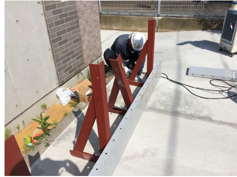
図 3-3-2 ブラケット建て込みと鋼製壁組み立て
