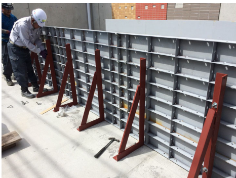
図 3-3-3 側壁組み立て
