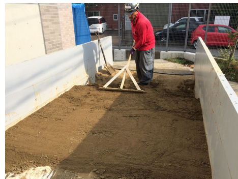
図 3-3-12 砂試料の撒き出し・敷き均し
