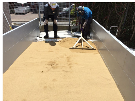
図 3-3-8 干渉層表面の不陸修正
