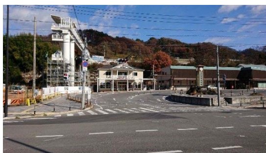
図 4-1 N 駅駅前広場の全景
