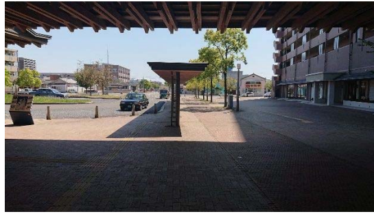
図 1-7 駅舎と同様のオリジナルデザインが採用された日向市駅駅前広場のシェルター 日向市駅では同様に、周辺街区で先行して地元産杉材を活用してオリジナルデザインで開発された照明柱やポラード，地域の色を選定したサインなども採用されている。
