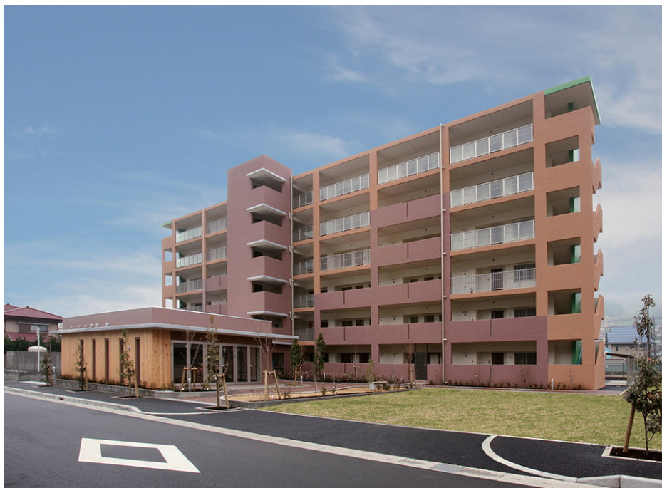
図2.8 定住促進住宅（山北駅北側定住促進住宅） 2.4)
