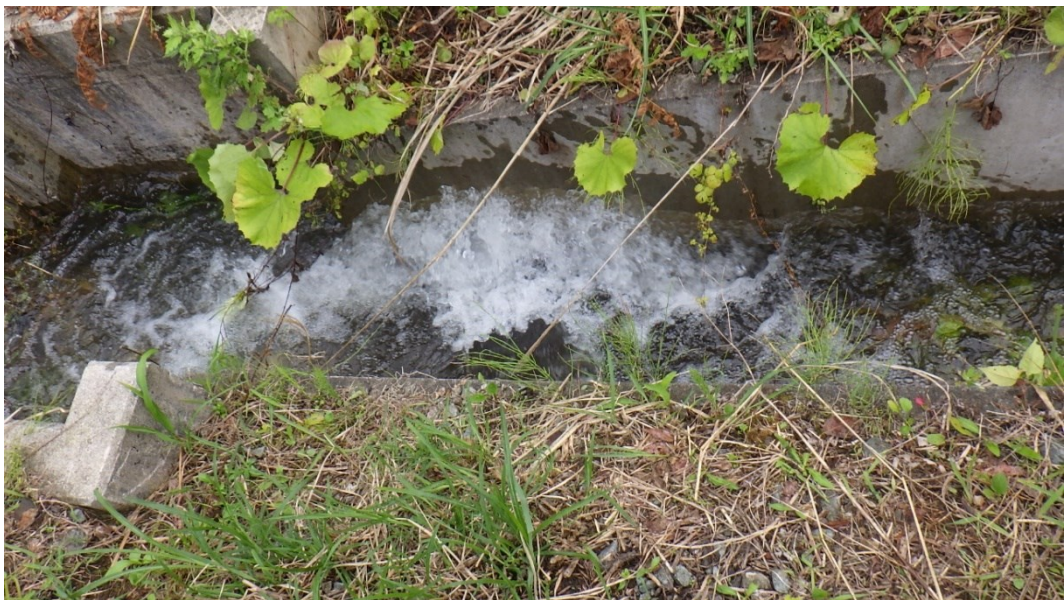
写真 4-7 排泥工から側溝へ水が流れ出ている様子
