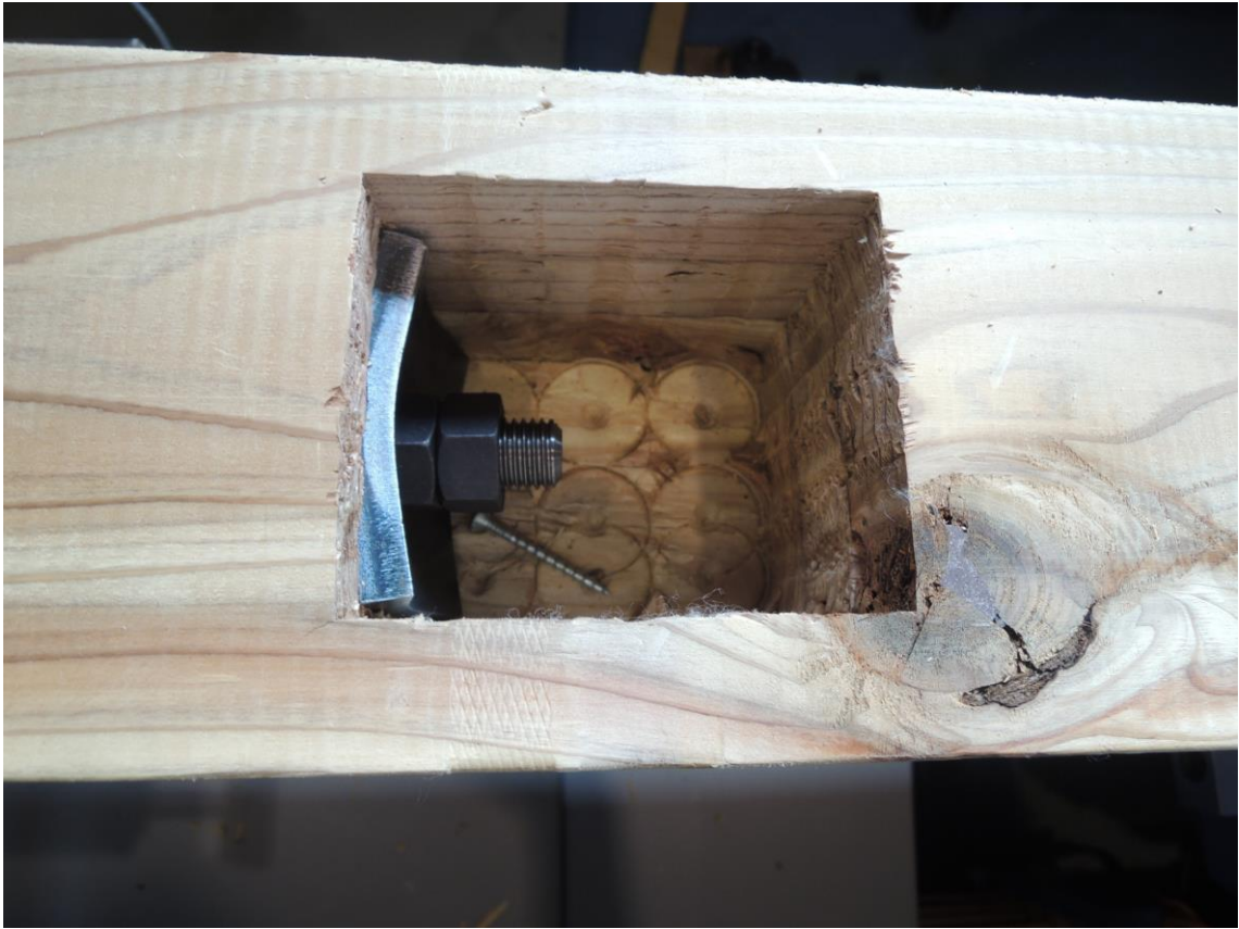
Figure 5.14 角ミノにより加工された座彫りの様子
