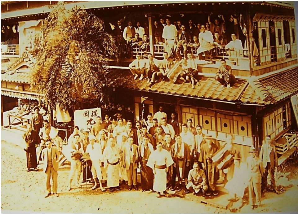
図 5A-5 図 5A-4 の異なる撮影地点からの写真
