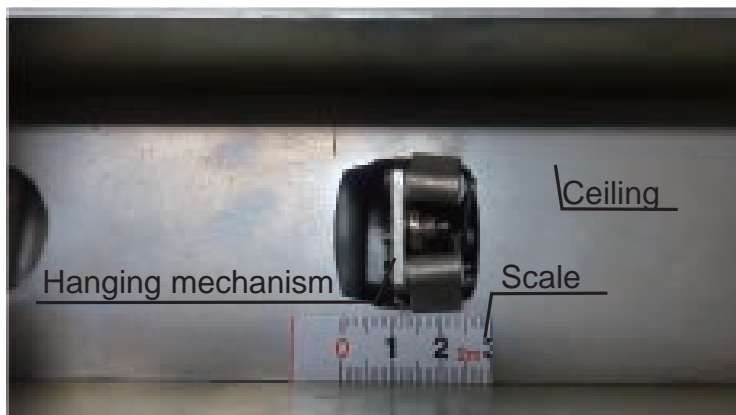
図 4.6 天井面に取り付けられた目盛りの外観
