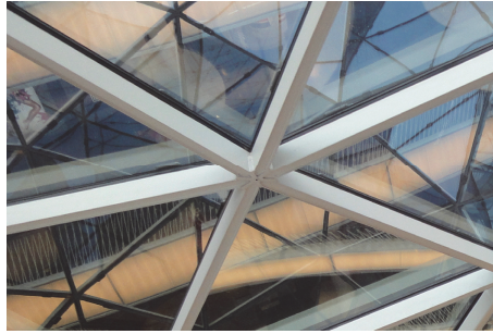
図 2-8 三角形モデルの支持部材接合部(MyZeil Shopping Mall)
