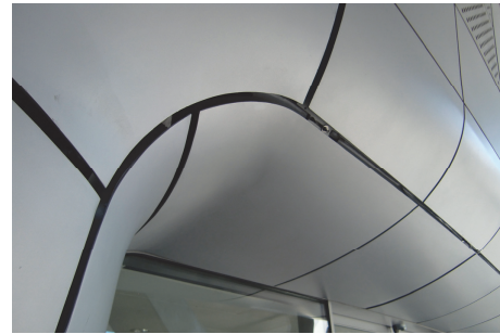
図 2-9 四角形モデルでの曲面パネルの利用(Dongdaemun Design Plaza)
