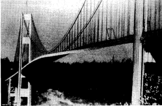
Fig.1.1 タコマ橋のねじり振動 [1]
