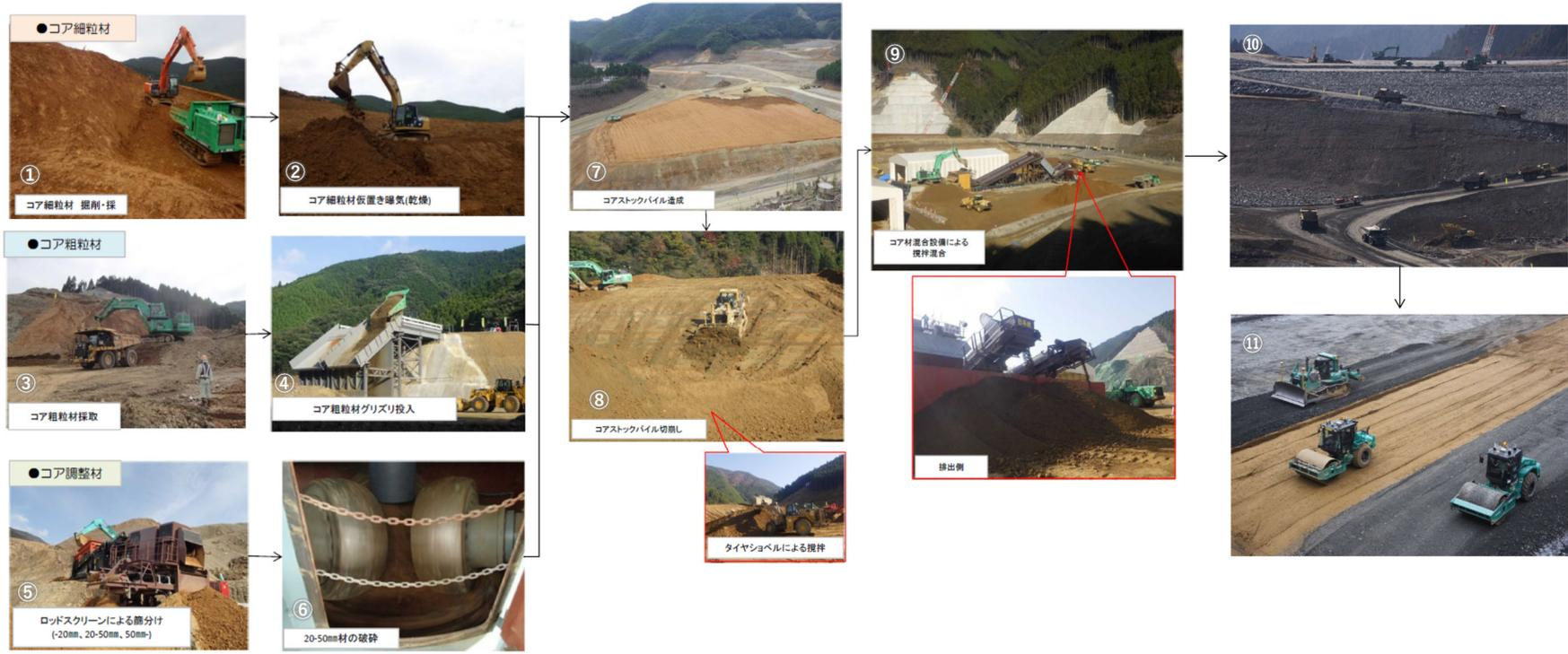
図-6.1 フィルダム遮水ゾーン建設の施工フロー (小石原川ダムの事例)
