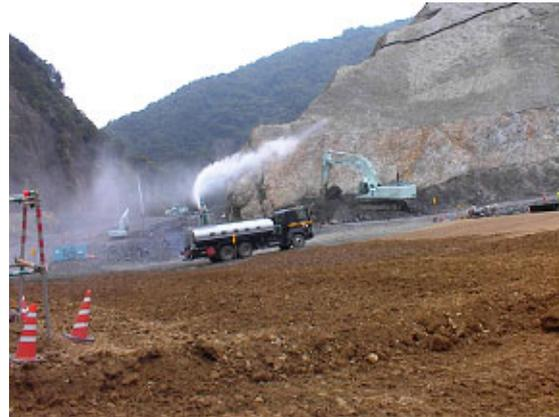
写真-6.6 盛立面の散水状況
