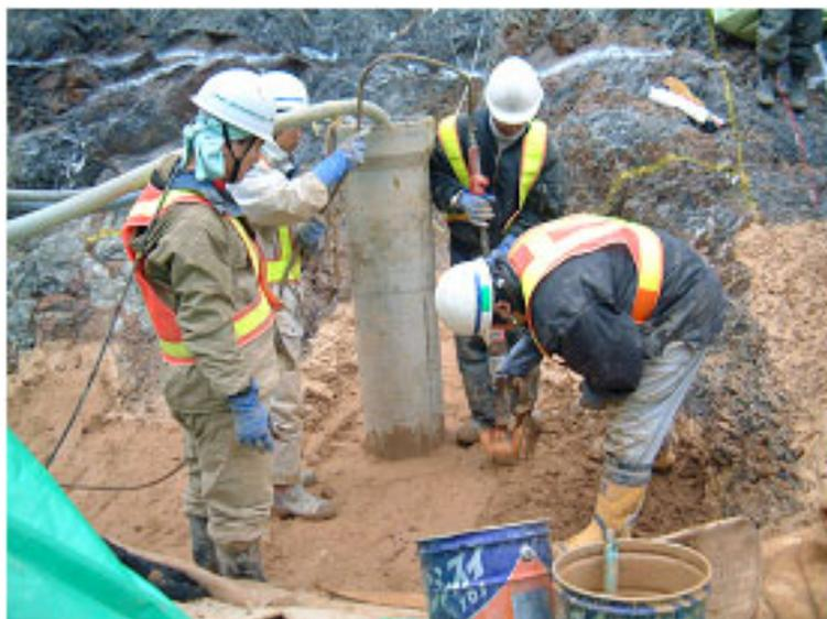
写真-6.5 湧水処理（ヒューム管）
