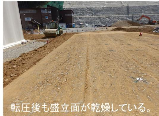
図-6.14 盛立試験の結果 (N=8) 【図-3.10 再掲＋一部加筆】
