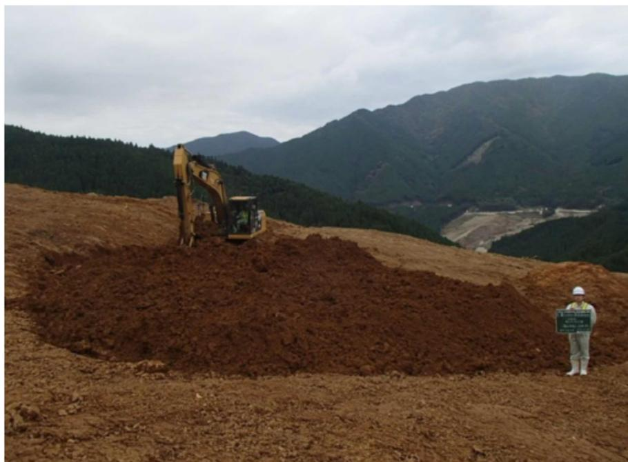
写真-6.3 材料の曝気処理状況
