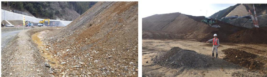
写真-6.3 パイル裾部の粗粒化と撤去例
