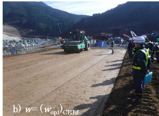
写真-6.11 施工含水比ごとの盛立面の含水状態
