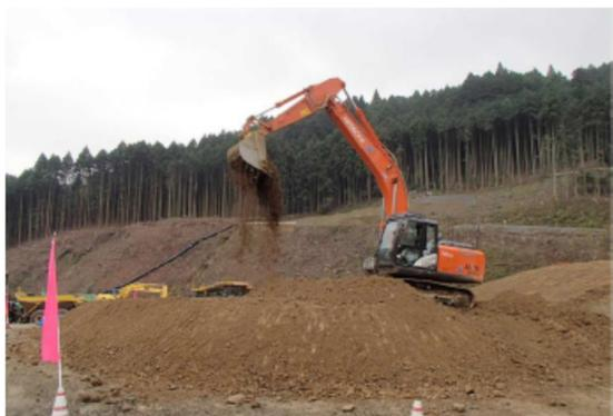
スケルトンバケットによる再混合
