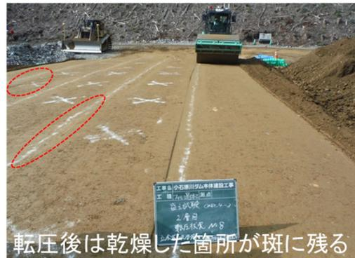
図-6.15 盛立試験の結果 (N=8) 【図-3.10 再掲＋一部加筆】
