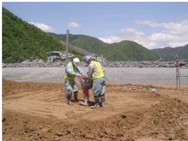
写真-6.7 計器周辺の先行施工の状況
