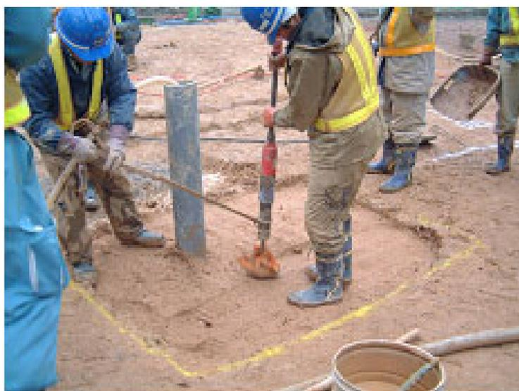
写真-6.4 湧水処理（塩ビパイプ）
