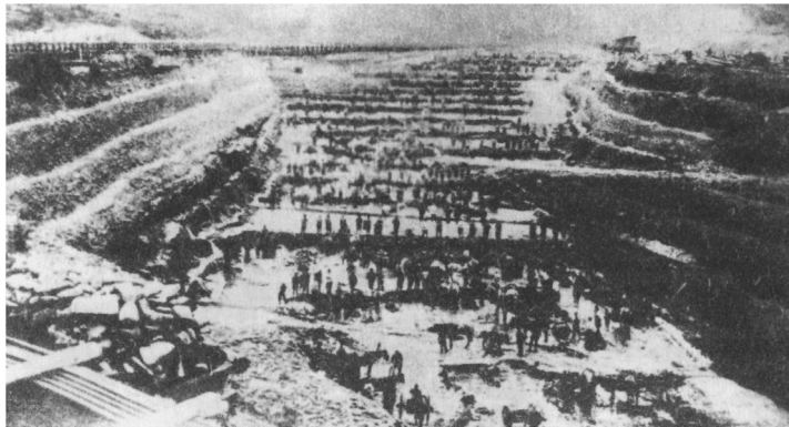
図 16 レナ金鉱の深く（25m）埋もれた砂金採集場からの、沖積層金採鉱の露天掘り
