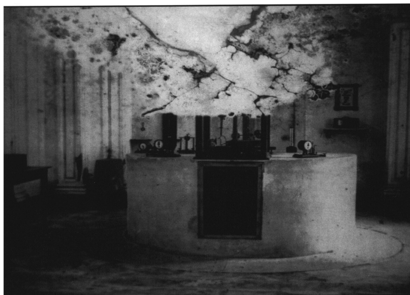
図 53 シャイド観測所の地震計が設置された架台
