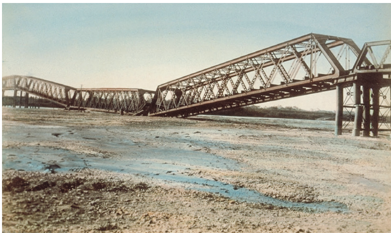
図 42 1891 年の地震後の ながらがわ 長良川に架かる鋼鉄の鉄道橋。この橋は 1888 年 1 月、英国人技術者 C.A.W. パウナルによって架けられた。5 つの部分のうち 3 つが崩落した。
