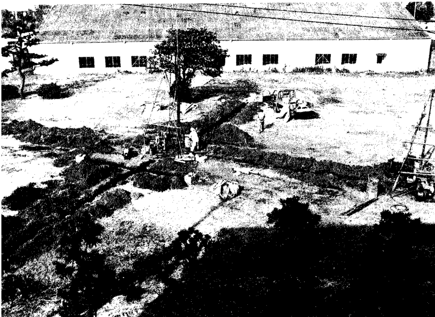
▲高密度地震計アレー観測に用いる地中地震計の埋設状況
