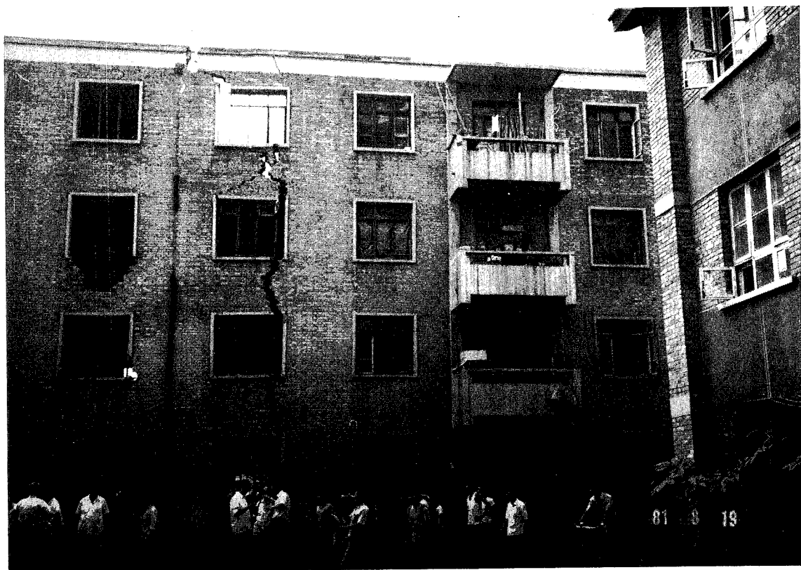
▲写真9 天津市の地盤のすべりによって損傷したアパート (龍岡撮影)
