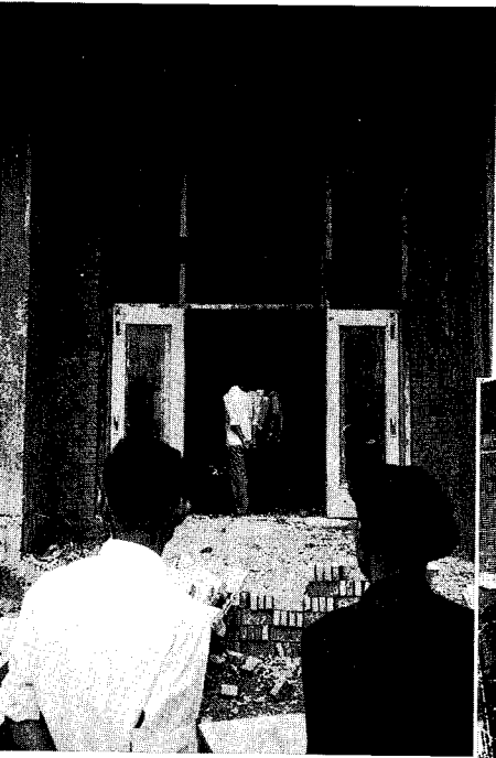
◀写真12 RC部材が主要な箇所に用いられた新築中のビル（海城県）（片山撮影）
