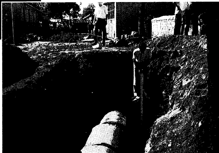
▼写真3 第十中学校校庭の断層(唐山一古冶)上にあった下水道管路 (片山撮影)
