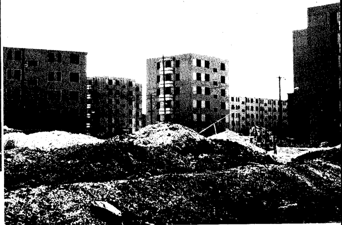
▲写真8 旧市街区に建設中のアパート群、約25万人 が入居する予定である (野中撮影)
