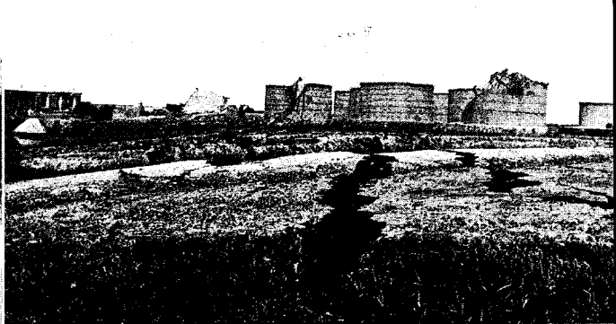
▲写真15 地盤のすべり (地盤液状化が主因とみられる) (天津市抗震弁公室提供)
