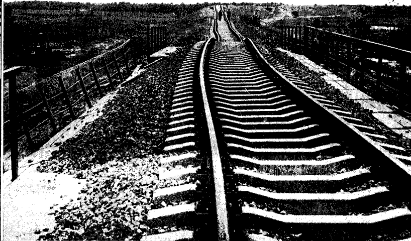
▲写真20 橋台裏の鉄道盛土の沈下 (中国建築科学研究院提供)
