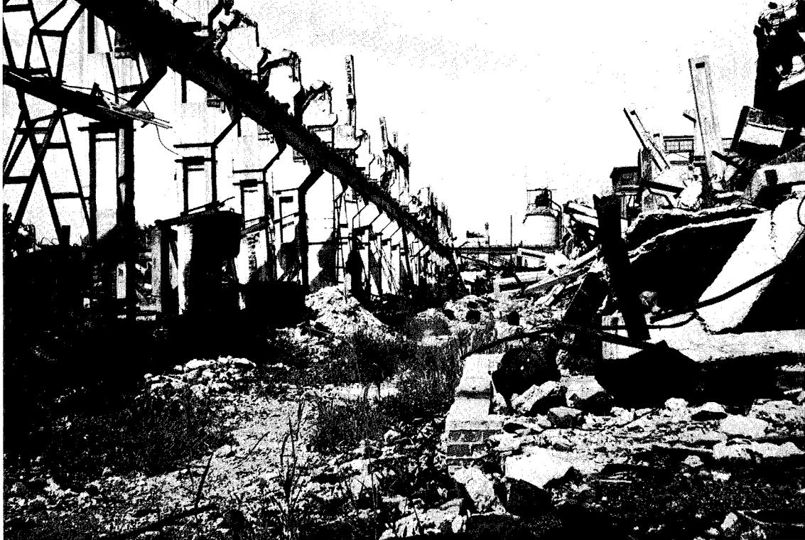
▲写真1 倒壊により8,700人もの死者を出した列車修理工場・地震前は年間170両の蒸気機関車、60両の客車を製造、470両を修理していた (片山撮影)
