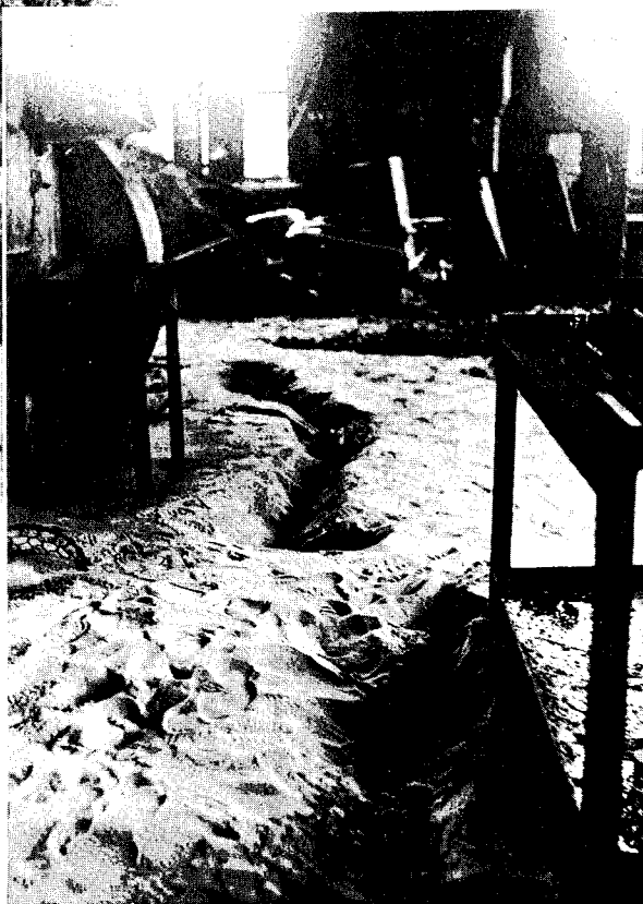
▲写真17 天津機械設備工場内部の噴砂のようす (一機部抗震弁公室提供)
