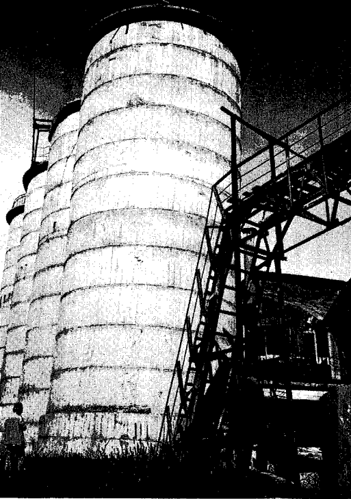
▲写真19 唐山市列車修理工場における砂サイロの地盤液状化による沈下・傾斜 (龍岡撮影)
