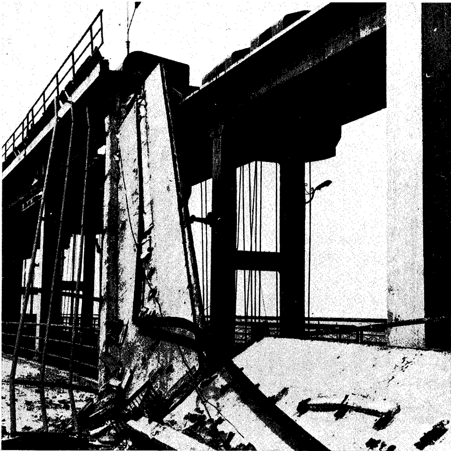
▲写真21 薊運河にかかっていたRC鉄道橋の桁の落下 (天津市抗震弁公室提供)
