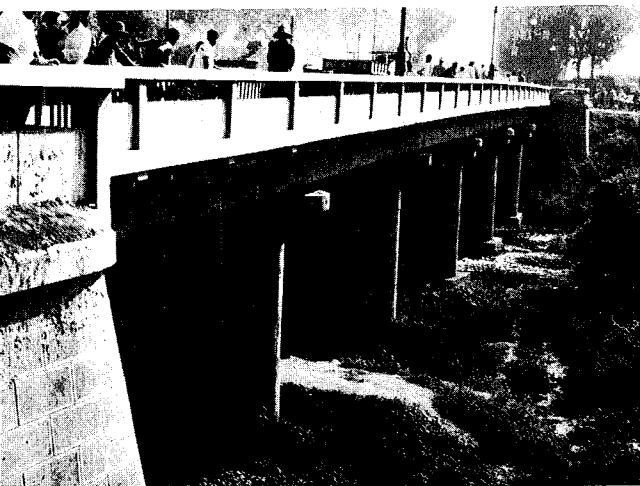
▲写真7 新しくかけ替えられた勝利橋 (野中撮影)
