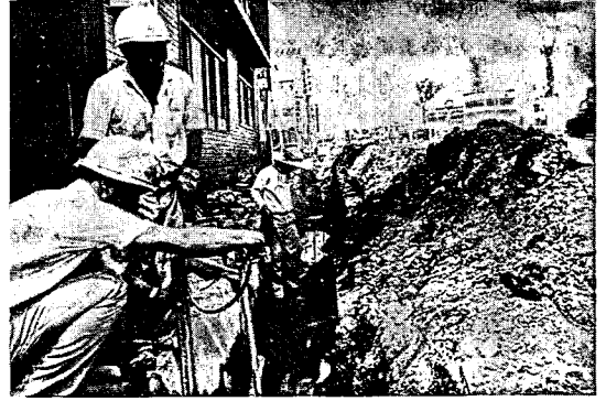
写真5 供給再開に向けての低圧管の気密テスト (北陸瓦斯(株)提供)
