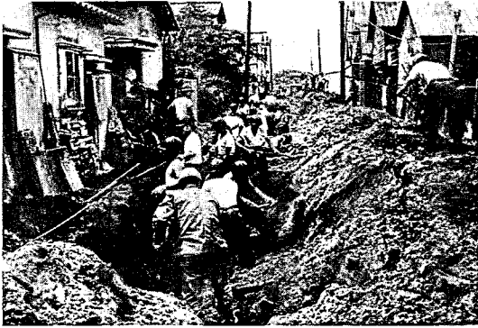
写真4 関屋工場寄りの輸送管・中圧管の掘起こし作業 (北陸瓦斯(株)提供)
