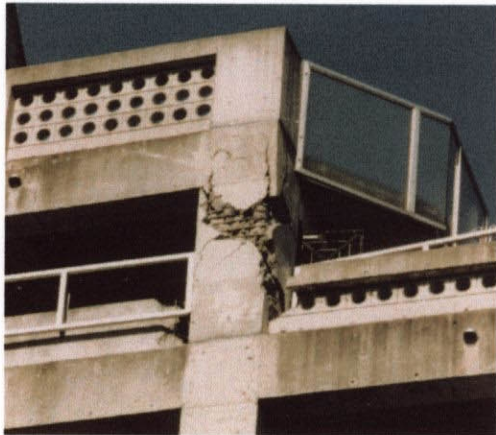
せん断ひび割れとコンクリートの剥落 写真A. 2.3 7階 X_1Y_4 柱
