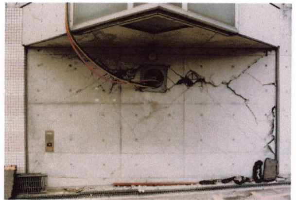
せん断すべり破壊 写真A. 2.4 1階非構造壁
