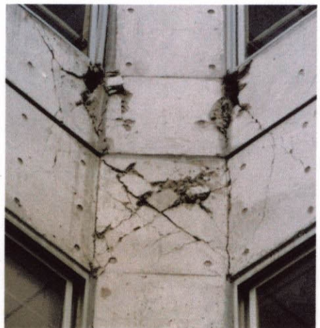
柱梁接合部コンクリートの圧壊・剥落 斜めの小梁と腰壁が取り付けられている 写真A. 2.2 X_1 通り柱梁接合部
