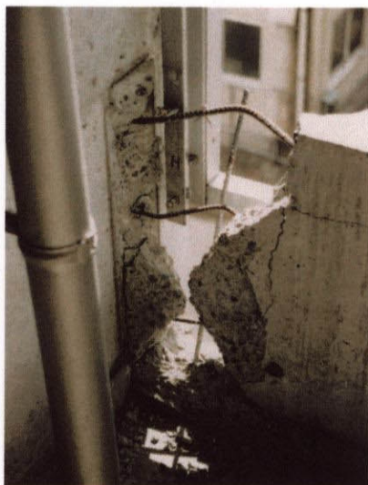
腰壁端の圧壊 写真A. 2.5 腰壁
