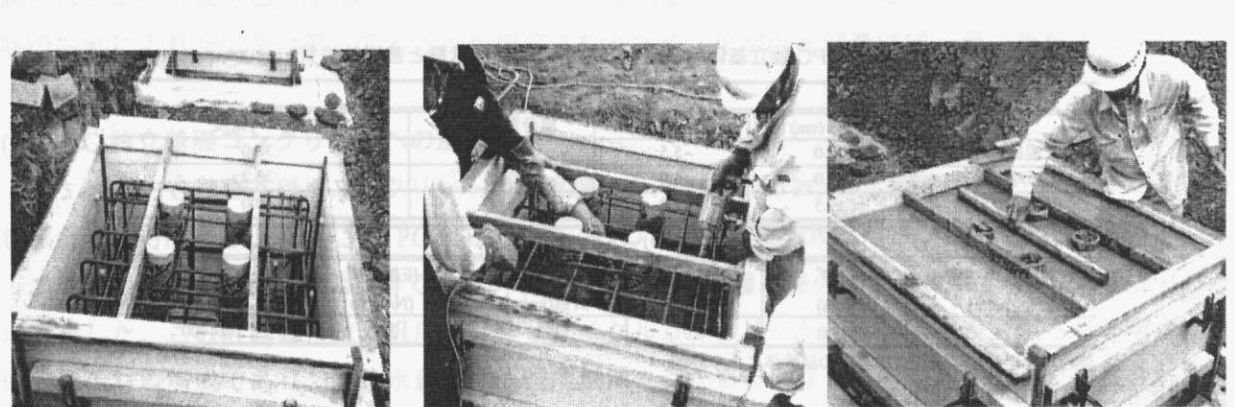
写真 5.4.2 PC 独立基礎型枠の状況／打設・締固め状況／表面仕上げ状態
