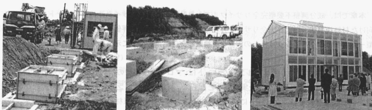
写真 5.4.3 仕上げ後 PC 独立基礎群／脱型後の PC 独立基礎／完全リサイクル住宅の全景
