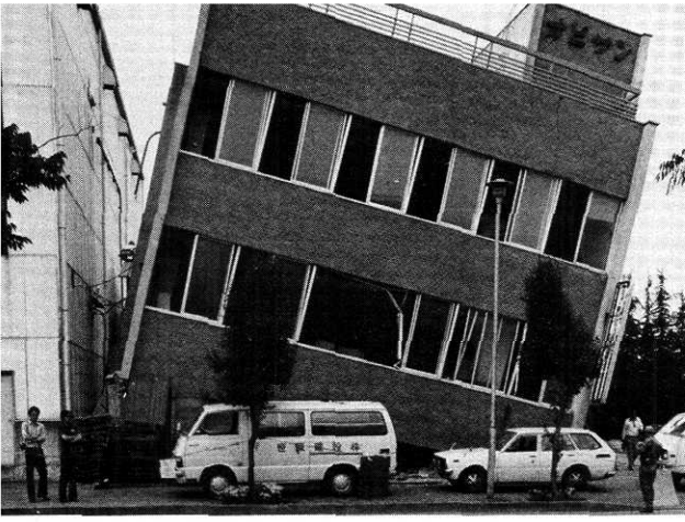
▲ 写真1 4本柱のピロティ建築 1960年代後半の建築
