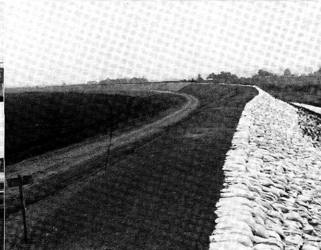
▼ 写真24 吉田川山崎堤防の緊急対策完了後の状況
