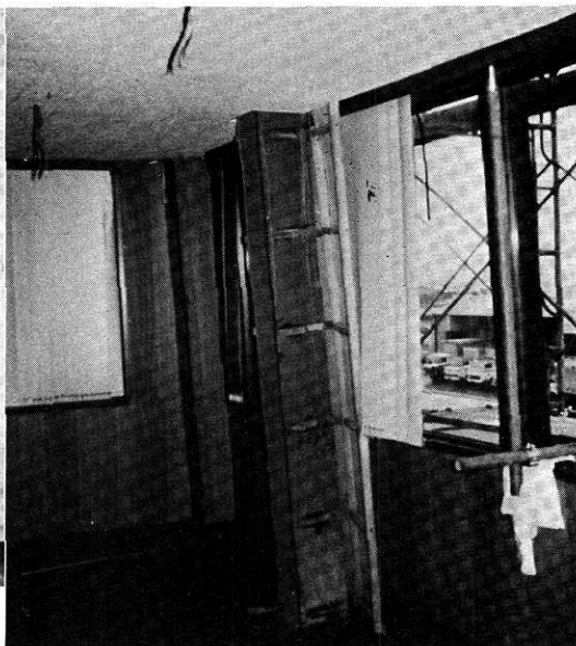
▼ 写真12 モルタル外壁の剥落。取付金物や針金は腐蝕によってなくなっており、外壁を固定する役に立っていない
