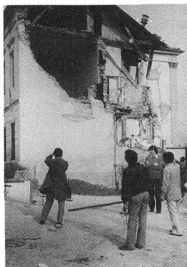
写真3 レンガ壁の面外への倒壊（クライオバ市）
