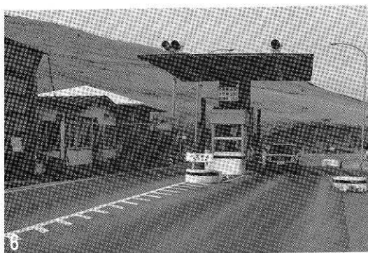
16 転倒前の小田野池料金所 (日本道路公団提供)
