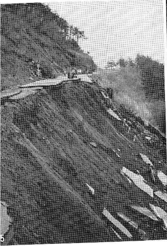
5 別府阿蘇道路の崩壊 (日本道路公団提供)
