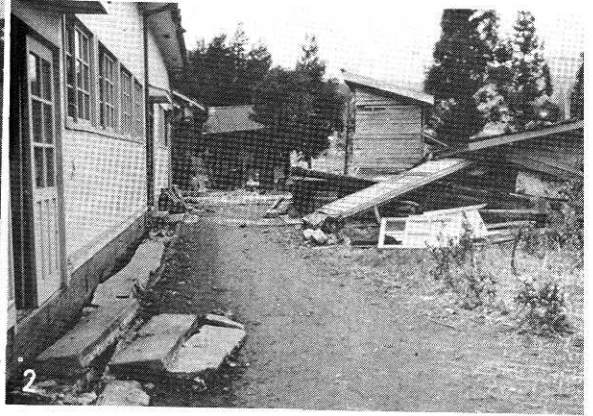
2 野矢小学校寺床分校物置の被害
