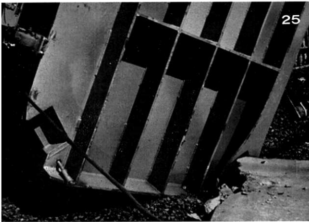
25. 写真 21 と同じ系列のリアクタ。アンカの方式が異なっている。ボルトが抜けている。(撮影 柴田)
