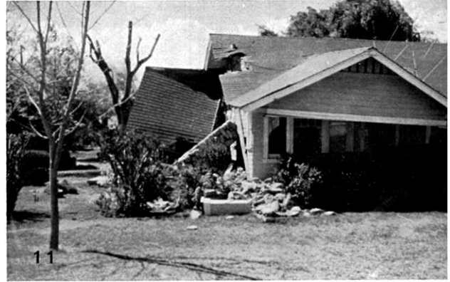
11. Sylmar 地区でみられた被害で、断層によるとされる地盤の永久変位のため、地変上の民家が被災した。(撮影 田村)
