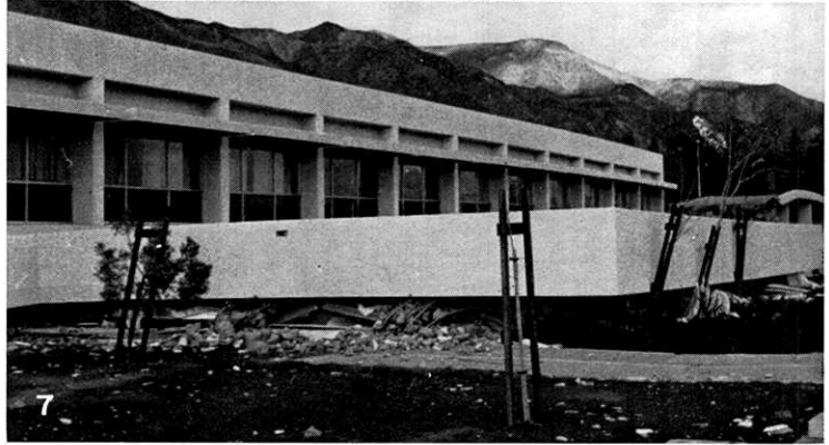
6. 5. の本館 1 階. 北側へ約 50 cm の永久変形を生じている. 鉄筋は 57 mmφ である。 (撮影 柴田)
