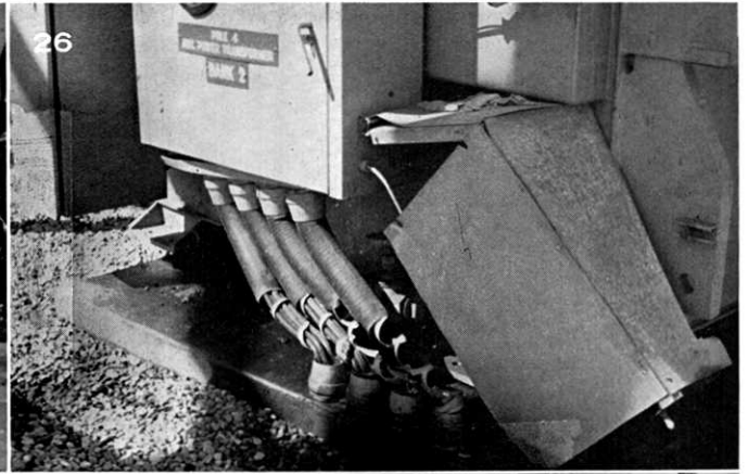
26. 写真 21 と同じ変換所の補助トランスの横ずれ。(撮影 柴田)
