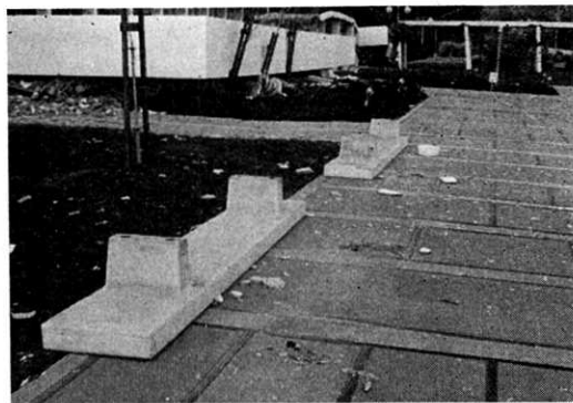
写真 1 口絵 6 の建物前面にあったベンチ。アンカボルトが抜けて、うら返しになっている。(撮影 柴田)
