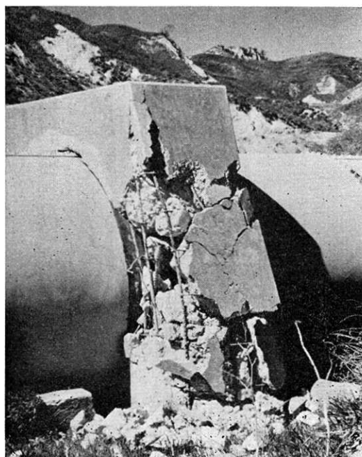
写真 5 固定台の破壊
