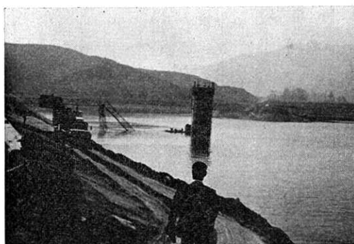
写真2 Upper Dam 上流面の破壊
