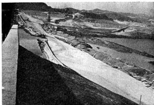
写真1 Lower Dam 破壊の状況
