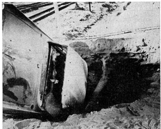
写真3 San Fernando Rd. ガスパイプの破損による爆裂孔に落ちた自動車 (Southern California Gas Co. 発行 Gas News より)
