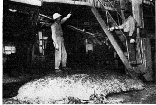
写真8 Saugas におけるガラス工場の炉の破損によるガラス生地の流出 (東京都提供, UPI 撮影)。
