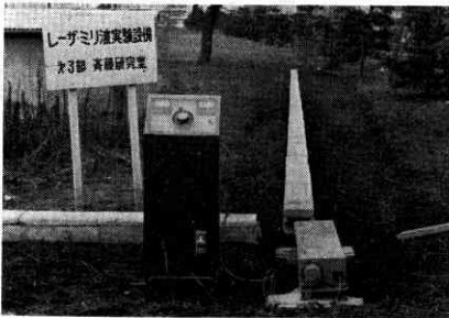
写真2 レーザと伝送路
