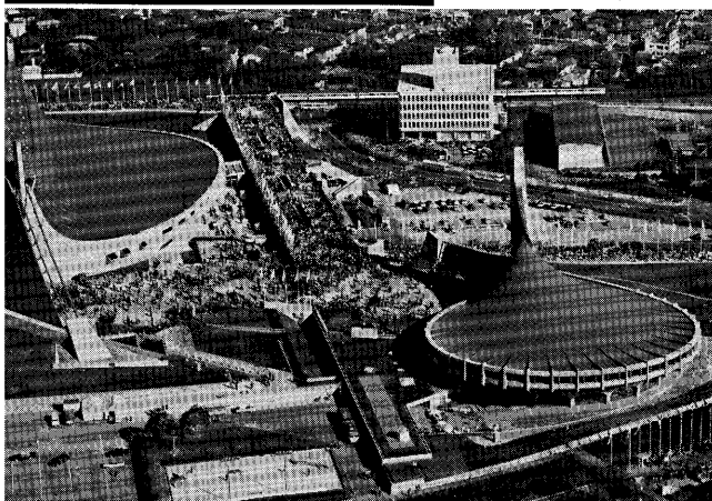
⇧ 国立屋内総合競技場の 吊り屋根構造 構造設計—坪井・川股 研究室—
