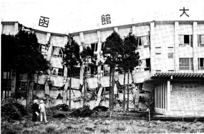
㉑函館大学 —4階建校舎の崩壊した部分—
