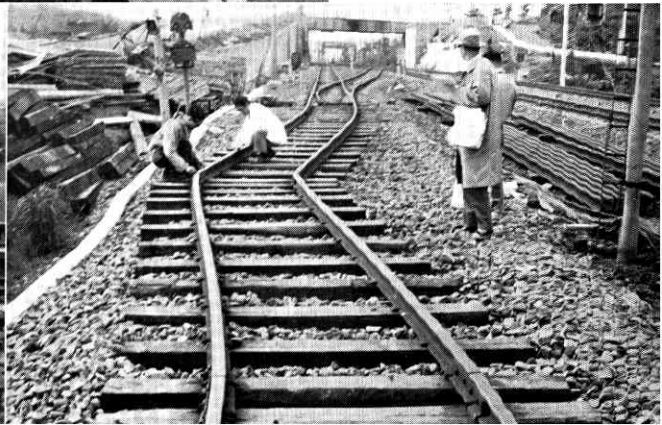
⑦米軍専用線のバックリング
