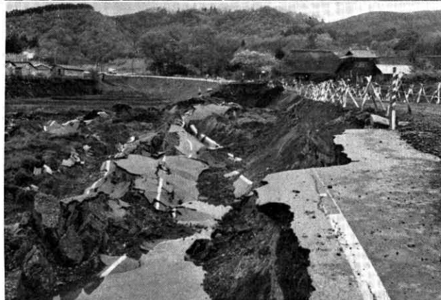
⑥国道の大崩壊
