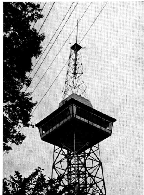
⑬部材がバックリングして傾いた八戸タワー
