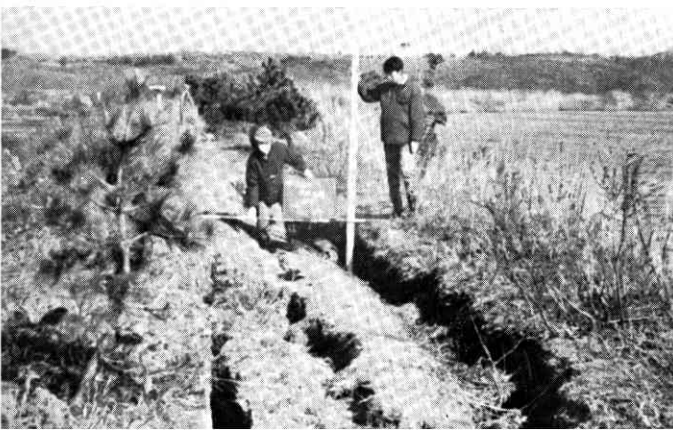
⑫堤頂に亀裂の入った中村溜池（青森県）
