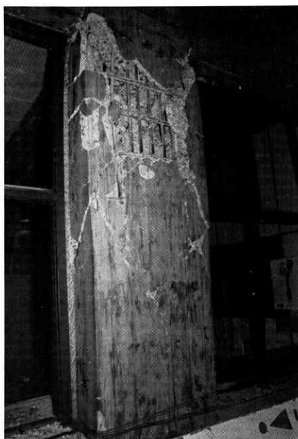
⑯八戸東高 —建物の一部の不同沈下および地下柱の崩壊により左方へ大きく傾いた—
