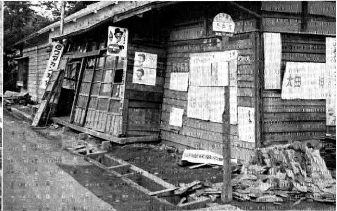
④移動し，変形した民家
