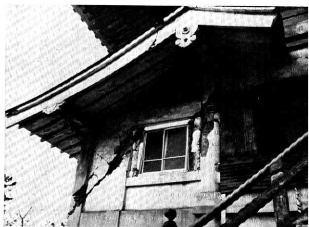
⑱来迎寺 —本堂と下屋の接合部分が破壊した—
