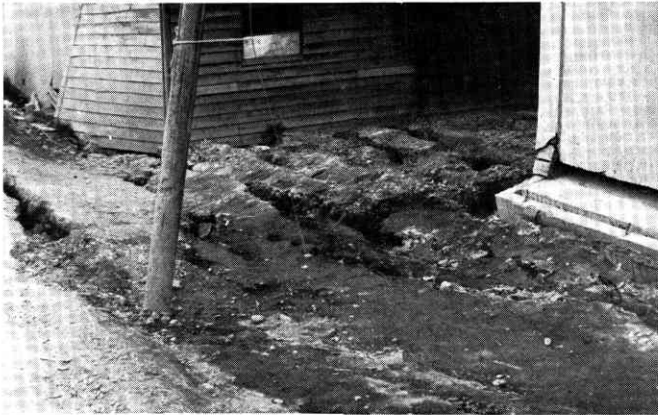
③地面の亀裂，移動
