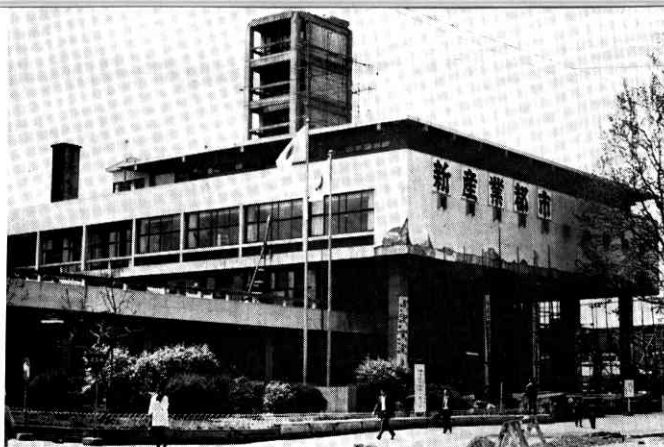
⑭八戸市庁舎 —ベントハウス最上階が倒壊した—
