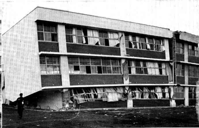
㉒三沢商高 —増築部分の柱が崩壊し、校舎は大きく傾斜した—
