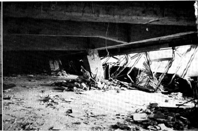
㉔むつ市庁舎 —3階建庁舎の3階の一部が崩壊した。写真はその内部—
