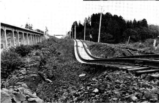
⑥小川原架橋付近，鉄道 盛土の滑動沈下
