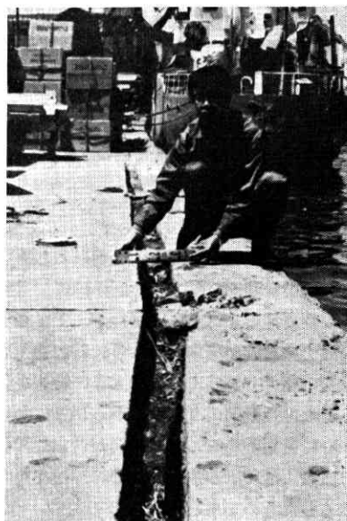
②⑤ 安方物揚場岸壁が約30m滑動 (青森市提供)
