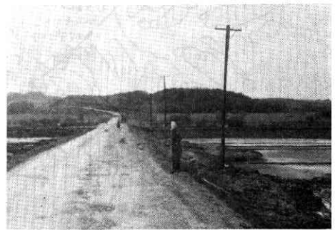
⑰低い盛土道路の亀裂・滑動 (上北町-三沢市)
