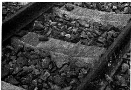
②③ 枕木の間のもま れた碎石 (同上)
