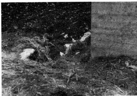
⑧ 矩形槽の周囲の土の沈下 (同上)
