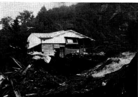
⑬ 山腹崩落・流動 (同上)
