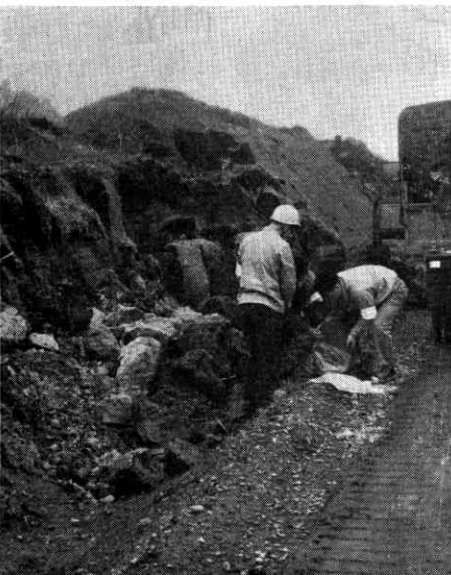
⑳切土部の崩落 (東北本線向山駅付近)
