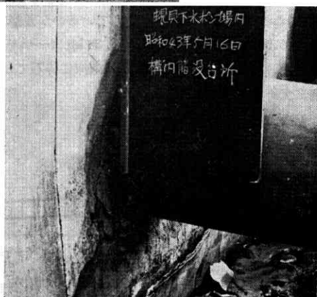
②⑨ 蛎貝下水ポン プ場構内陥没 (青森市提供)
