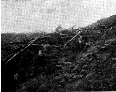
⑯法面崩壊 (国道4号線吉谷池)
