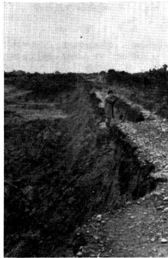
㉑ 決壊した一里小屋ダムで残った左岸部 (青森県土地改良部提供)
