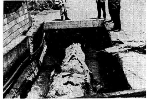
③せり上がったコンクリートの川底 (青森市提供)
