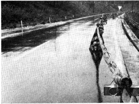
⑭路肩沈下 (国道4号線沼宮内)
