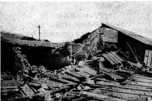
写真 3 震央付近での民家の被害
