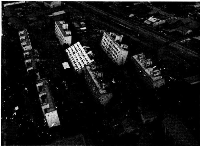
写真 2.2 新潟地震で転倒した川岸町アパート (新潟市)
