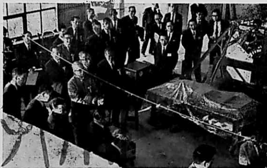
アーチダムの模型振動実験を見学する来賓
