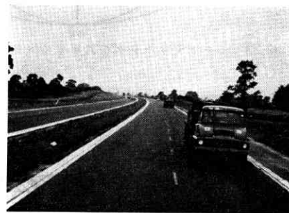
写真4 イギリスのモータウエイ M1。 (ロンドン-パーミンガムを結ぶものだが、かなり傷みの出ているところがあり設計も評判がよくない)
