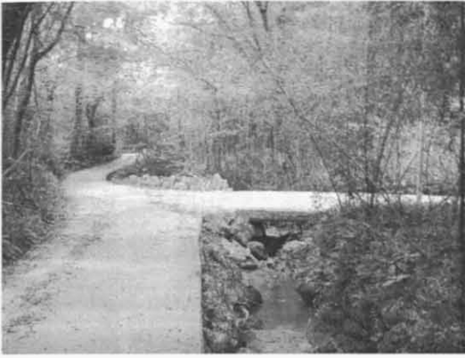
i) コンクリート舗装された散歩路
