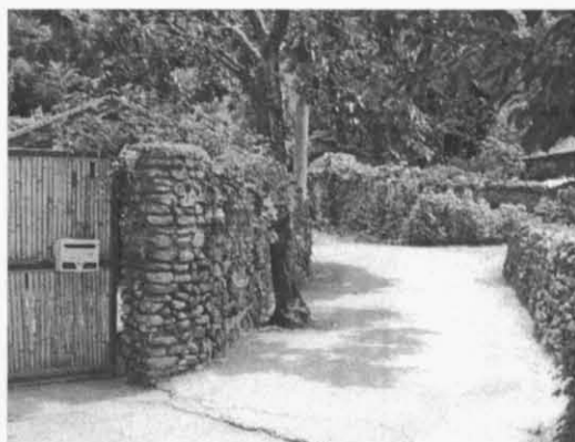
ii) 住宅及び石垣
