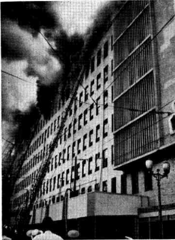
西部百貨店の火災現場 火は7階から出て7人の死者と115人の傷者を出し、8階まで延焼して7時間にわたって火災がつづいた。
