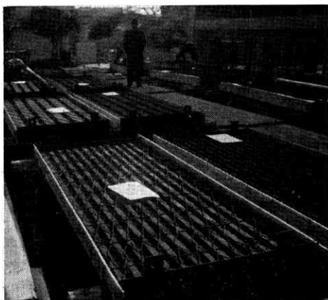
第3図 デッキプレートと斜材を組み合わせた床パネル この上に軽量コンクリートを打ち込んだ床が多く使われる。耐火性を高めるために下面から石綿や岩綿を吹付けると有利になる
