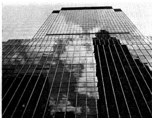
第 5 図 アメリカでよくみられるガラスのカーテンウォール
