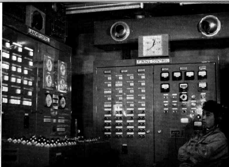
↑ ロケット・センタ 半地下室内のランチャ管制盤とイグナイタ管制盤
