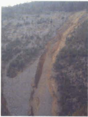
写真 4-2 皆伐した斜面より崩落する土砂
