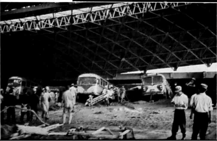
新潟交通株式会社 車庫 鉄骨屋根を支える 柱が、向う側に隣 接する鉄筋コンク リート4階建の独 身寮と共通の基礎 上にあり、独身寮 の沈下に伴って沈 下した。
