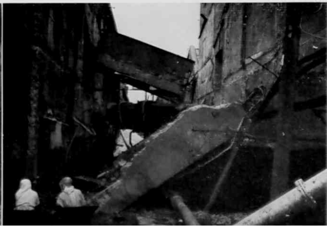
⑥ 建物間を結ぶ通路に取り付けられた配管の被害は大きい(次ページ最初の図参照)。
