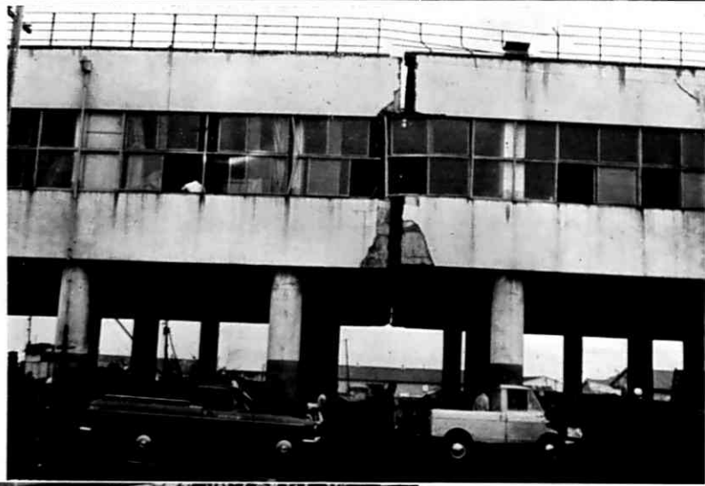
東洋埠頭倉庫 岸壁に接する盛り土の 移動、沈下による破壊。
