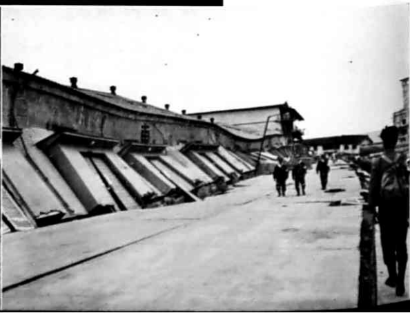
東洋埠頭倉庫 岸壁に接する盛り土の 移動、沈下による破壊。
