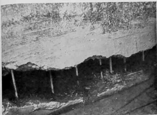
写真 1 八千代橋橋脚鉄筋切断状況
