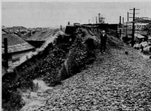
写真6 築堤沈下の1例
